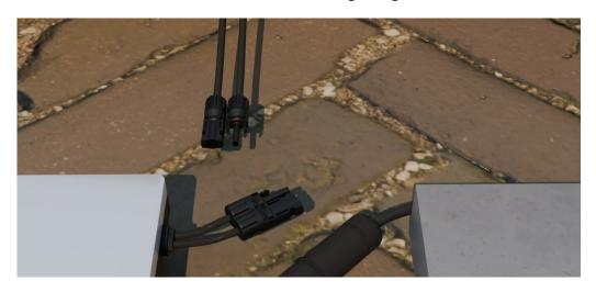
Nehmen Sie anschließend das zweite Modul und lehnen es an den hervorgehobenen Kanten der zwei verbliebenen kleinen Stützen an. Dieser Anschlag verhindert ein Verrutschen. Halten Sie das Modul fest und verbinden Sie die DC-Kabel des Moduls mit dem Wechselrichter. Nun können Sie das Modul auf den beiden verbliebenen großen Stützen ablegen.
