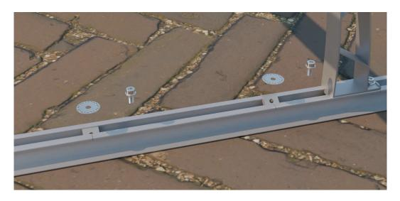
Positionieren Sie anschließend das Loch der Ballastschienen über dem Nutenstein und schrauben mittels Flanschschrauben die Ballastschienen an der Basisschiene fest. Wiederholen Sie diesen Vorgang für alle Schraubverbindungen der Ballastschienen.
