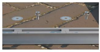
Setzen Sie an die markierten Positionen je einen Nutenstein und legen die Erdungsplatten drauf.
