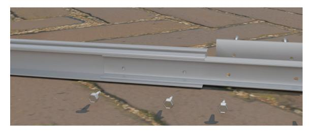
Nehmen Sie den zweiten Schienenverbinder und wiederholen den Vorgang auf der gegenüberliegenden Seite der gleichen Schiene.
