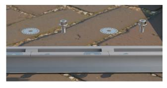
Setzen Sie an die markierten Positionen je einen Nutenstein und legen die Erdungsplatten darauf.
