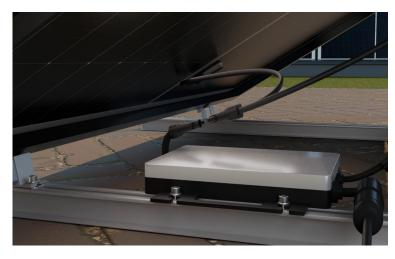
Nehmen Sie anschließend das zweite Modul und lehnen es an den hervorgehobenen Kanten der zwei verbliebenen kleinen Stützen an. Dieser Anschlag verhindert ein Verrutschen. Halten Sie das Modul fest und verbinden Sie die DC-Kabel des Moduls mit dem Wechselrichter. Nun können Sie das Modul auf den beiden verbliebenen großen Stützen ablegen.
