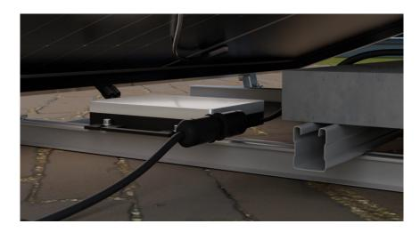
Richten Sie beide Module so aus, dass Sie auf beiden Seiten der Stützen den gleichen Abstand zum Modulrand haben.
