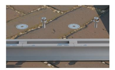
Setzen Sie an den markierten Positionen je einen Nutenstein und legen die Erdungsplatten darauf.
