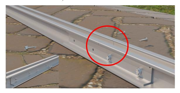
Legen Sie anschließend die zwei Basisschienen eng aneinander und richten diese parallel zu einander aus.
