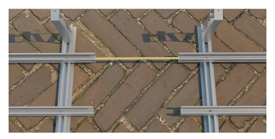
In Abhängigkeit vom Wechselrichter-Hersteller\*, messen Sie auf einer Innenseite der Ballastschiene 24 cm plus weitere 15 cm und markieren dies auf der Basisschiene.
