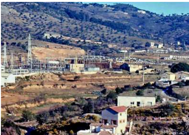
ENHER: Subestació de Sant Just Desvern. Fotografia: Jordi Farràs.
