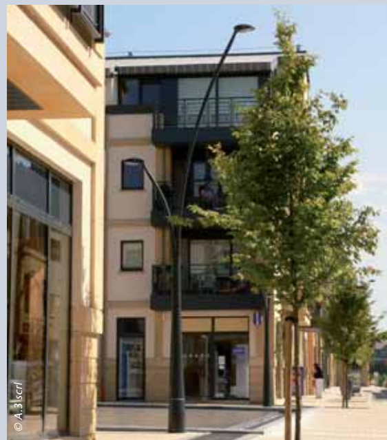
Le type d'éclairage à préconiser devra être économique, d'entretien aisé et permettra de limiter la pollution nocturne.
