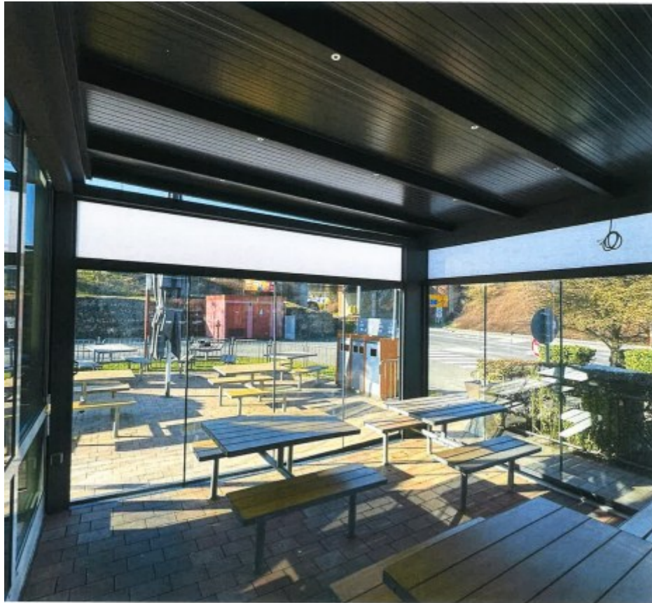
Pose d'une pergola en façade avant du bâtiment
