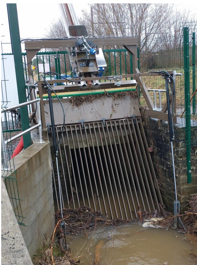
Figure 2-7 : Grille équipée d'un dégrilleur automatique sur le Wasser Grund, au niveau de l'entrée du puits de Longeau.
