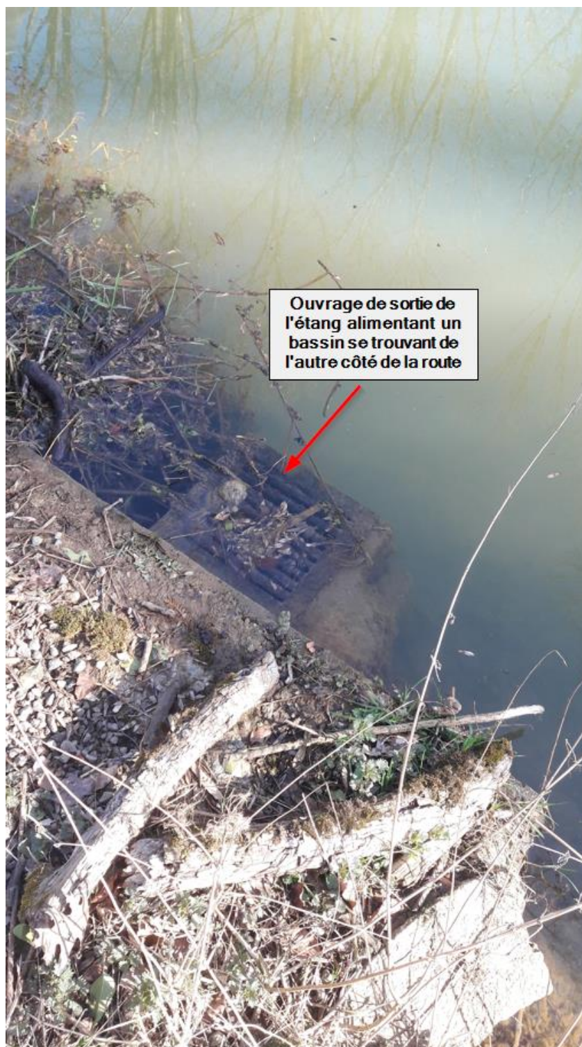
Figure 2-6 – Ouvrage de sortie de l'étang constituant une prise d'eau vers le bassin se trouvant de l'autre côté de la route.
