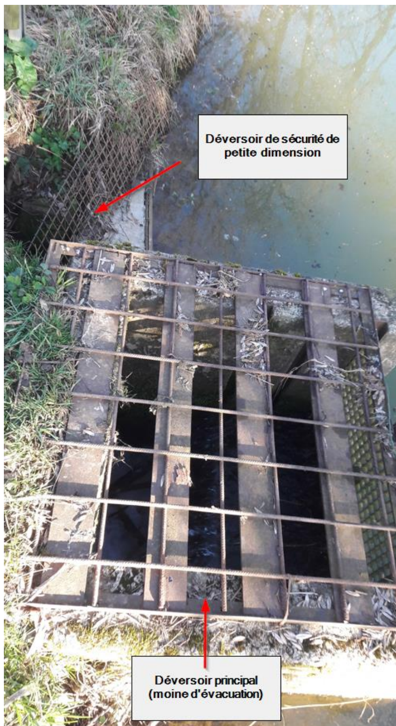
Figure 2-5 – Ouvrage de régulation principal et déversoir de sécurité en sortie de l'étang.
