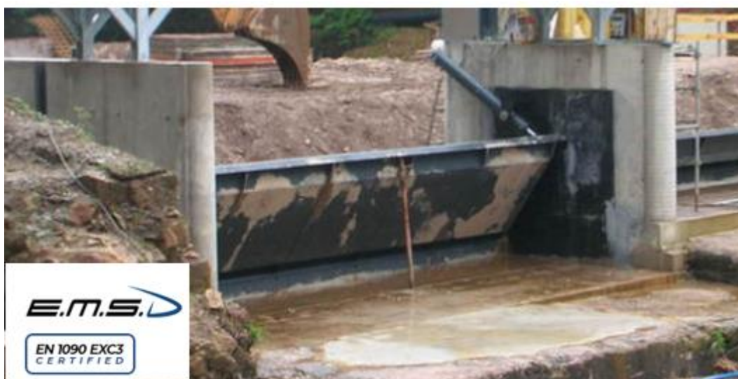
Figure 5-5 – Vanne de régulation automatique avec actionneur hydraulique – source : société EMSD-métal
