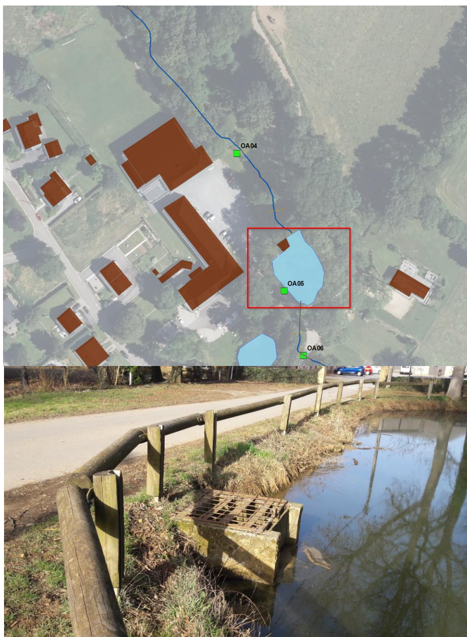
Figure 5-3- Localisation et vue sur l'ouvrage OA05 régulant le débit de sortie de l'étang.
