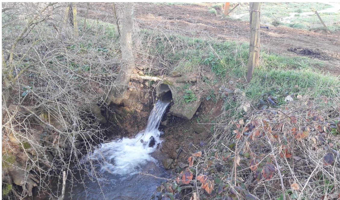
Figure 2-2-Fiche ouvrage du premier ouvrage du secteur (buse de diamètre D400).
