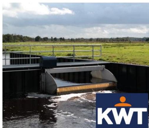
Figure 5-4- Vanne de régulation automatique - marque KWT.
