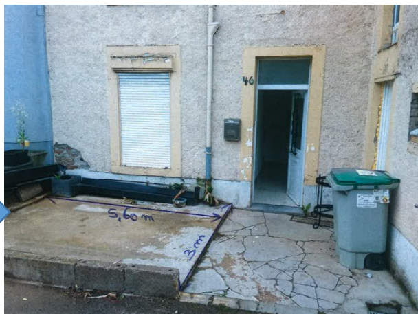
Installation de la pergola
