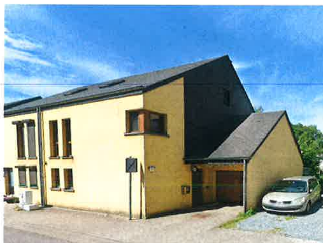
Remplacement de l'ensemble des menuiseries en PVC de teinte gris anthracite
