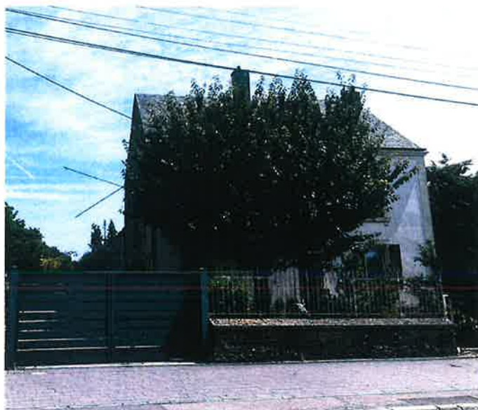
Vue depuis la voirie, façade avant
