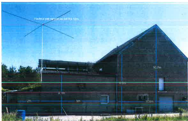
Vue depuis la façade latérale gauche
