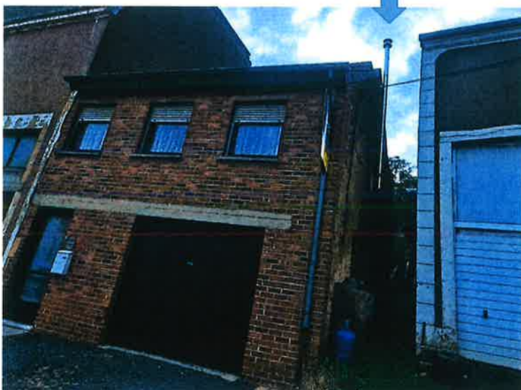
Situation à régulariser
