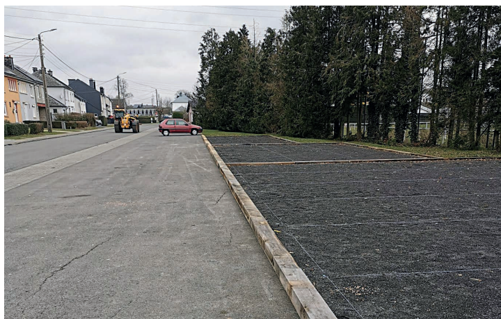
Rue du Stade, création d'un terrain de pétanque.
