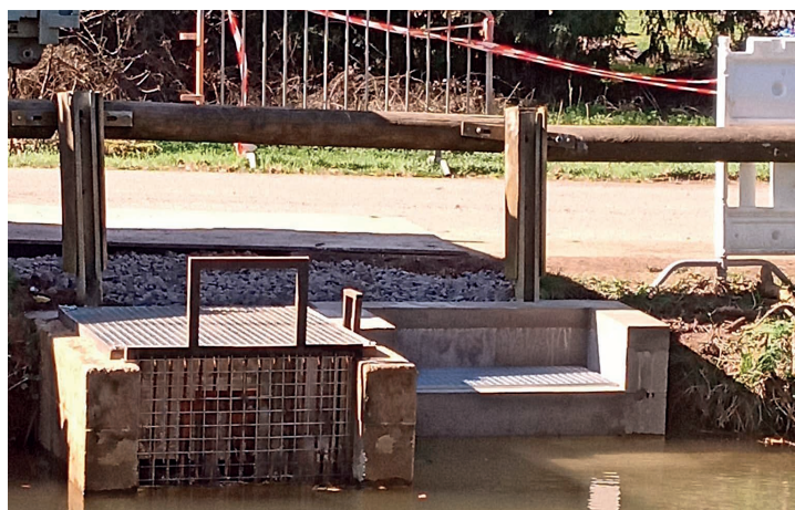
Remise en état du moine à Clémarais.
