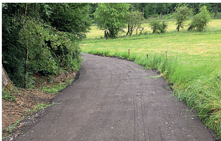
Aménagement du chemin rue de la Frontière en empièchement perméable.
