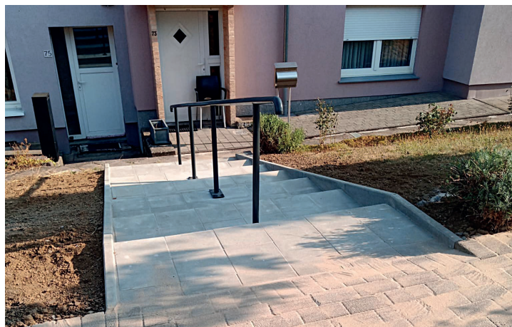
Remise en état d'un escalier et d'un garde-corps rue des Chasseurs ardennais.
