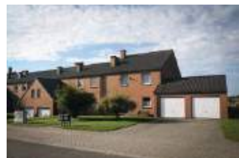
Rue des Hauts Droits à Gerpinnes
