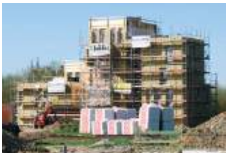
Constructions Closières à Mont-sur-Marchienne
