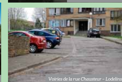
Voiries de la rue Chausteur - Lodelinsart
