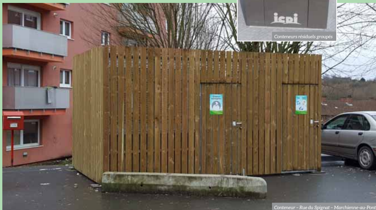
Conteneur - Rue du Spignat - Marchienne-au-Pont
