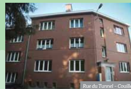
Rue du Tunnel - Couillet
