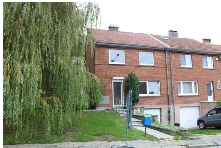
Rue Finet 2 à Goutroux
