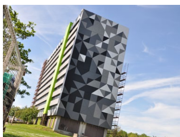
Rénovation énergétique Chili 4-6-8-12 à Marcinelle
