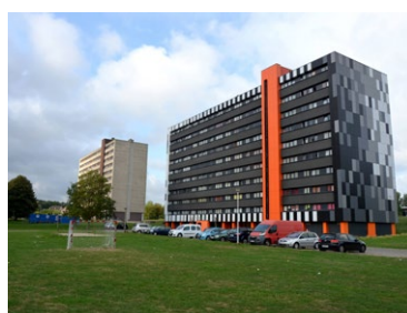
Rénovation énergétique Chili 4-6-8-12 à Marcinelle
