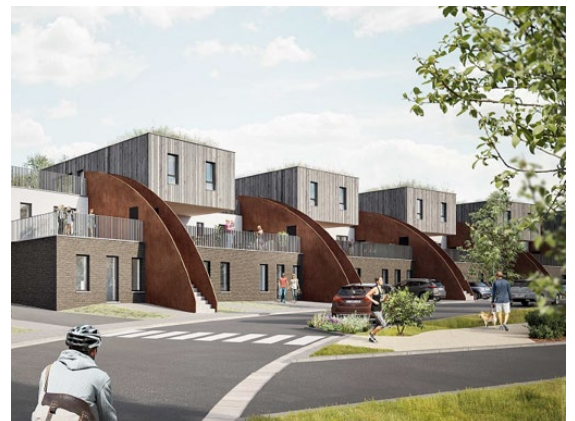
Solaire Eixample XII à Marcinelle
