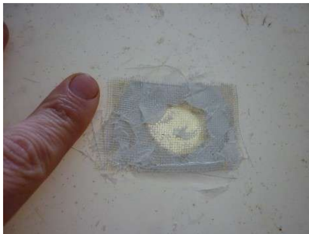
XXXX Photo A30 : Entrée d'air grillagée par une trame en nylon collée avec du mastique.
