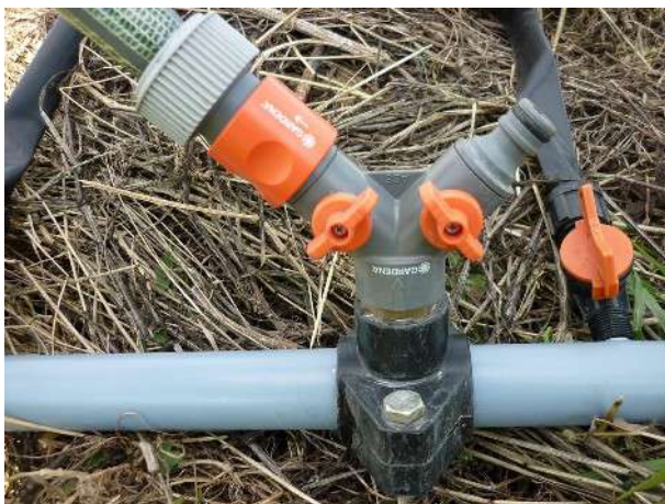
XXXX photo XX : Exemple de connexion rapide visée sur un « collier de prise en charge ».
