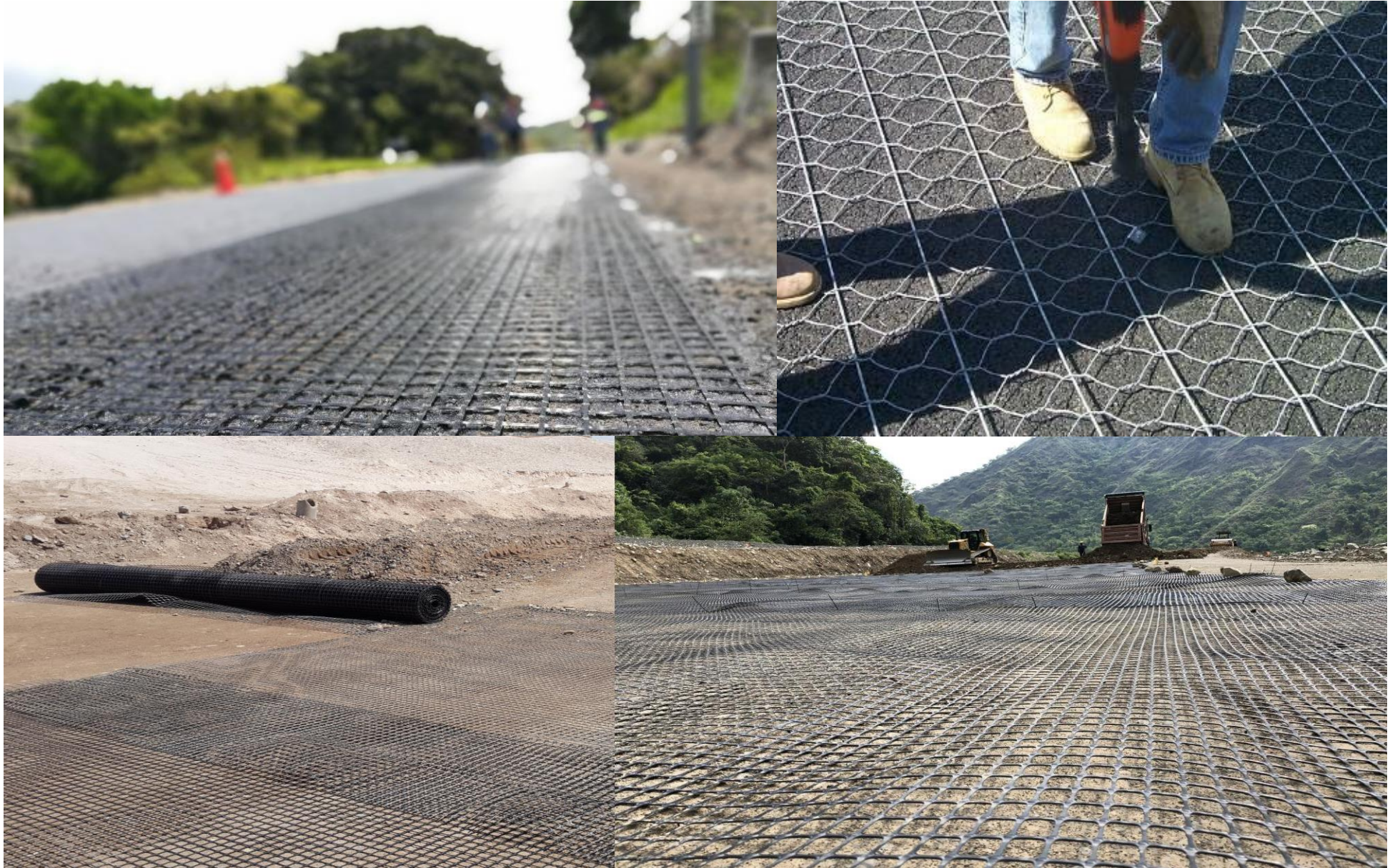
Refuerzo de la base del pavimento con geogrids MacGrid®
