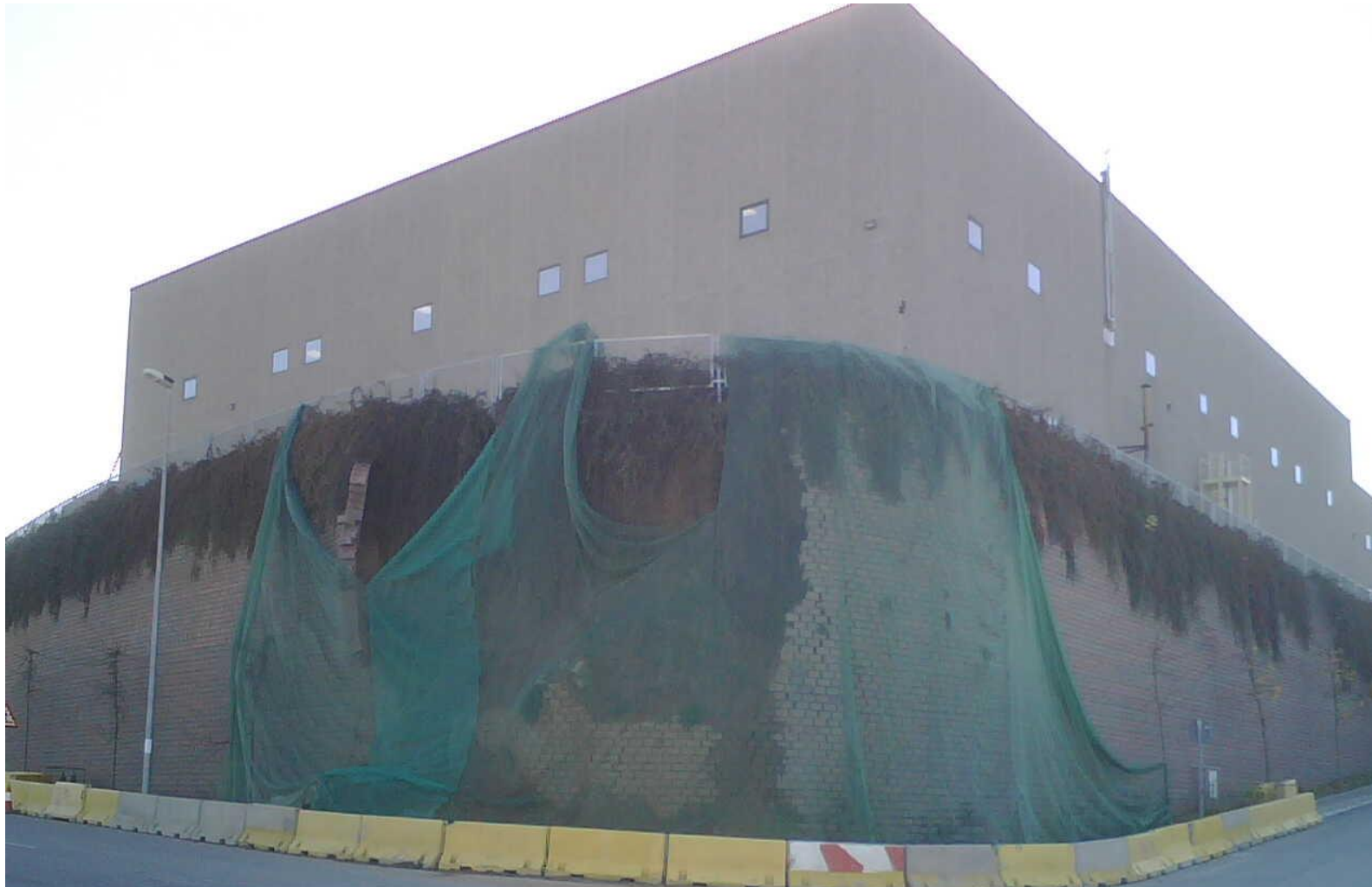
Falla de conexión del paramento
