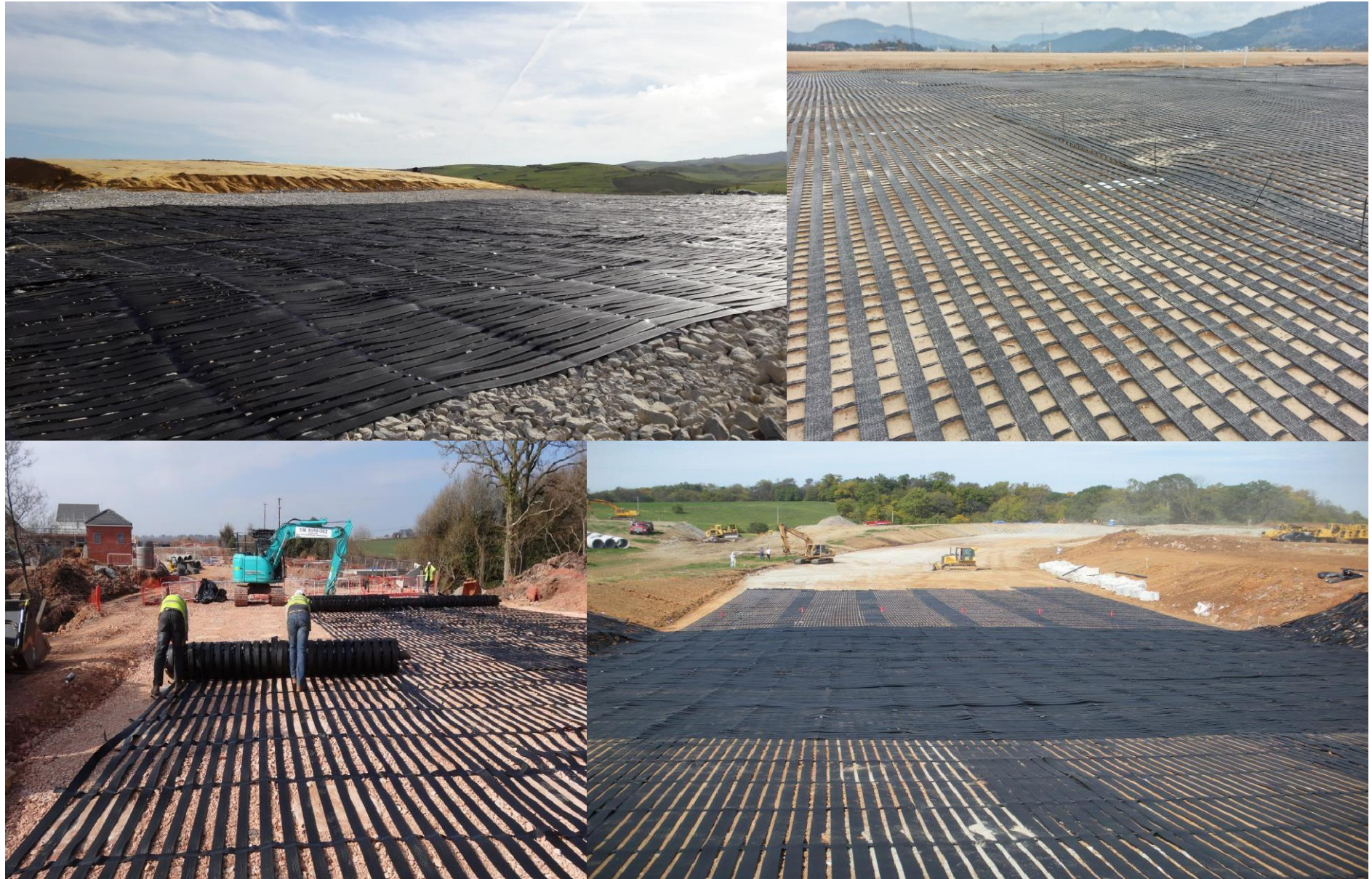
Refuerzo de terraplén sobre suelo blando con geogrilla MacGrid® e MacDrain® V
