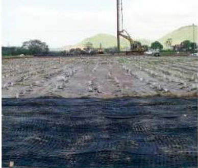
Refuerzo de terraplén sobre suelo blando con geogrilla MacGrid® e MacDrain® V
