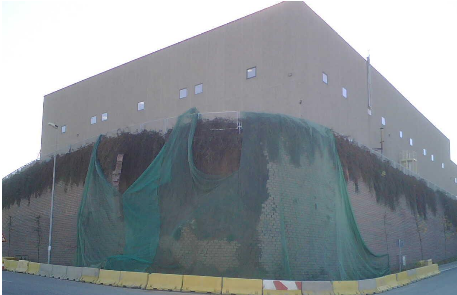
Falla de conexión del paramento
