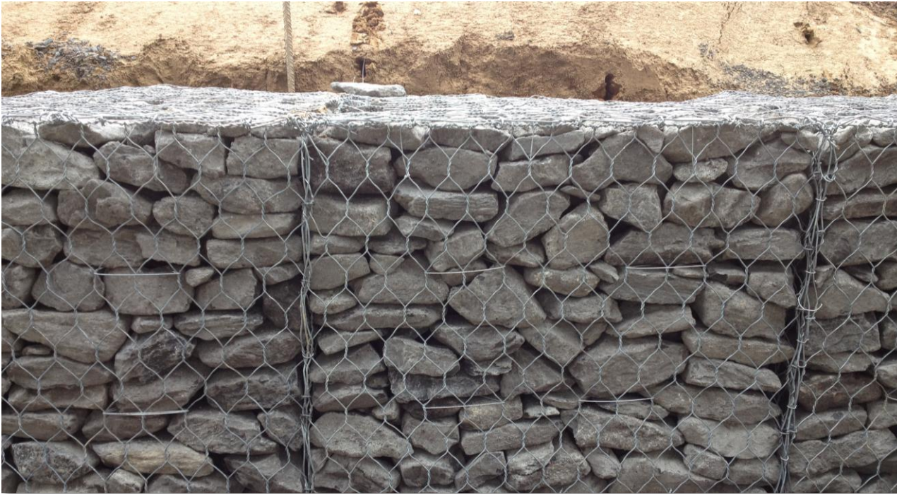
Appareillage des pierres au parement et mise en place des tirants ( \geq 4u/m^2 )
