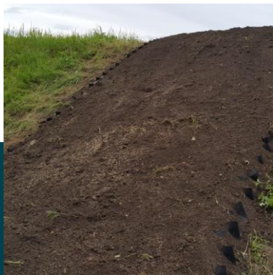
Protección del talud con Geoceldas después de la colocación del relleno
