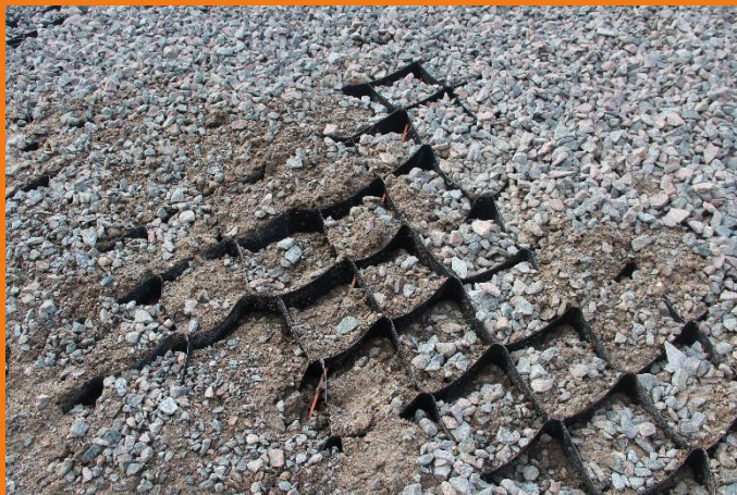
WASHOUT DEL MATERIALE DI RIEMPIMENTO
