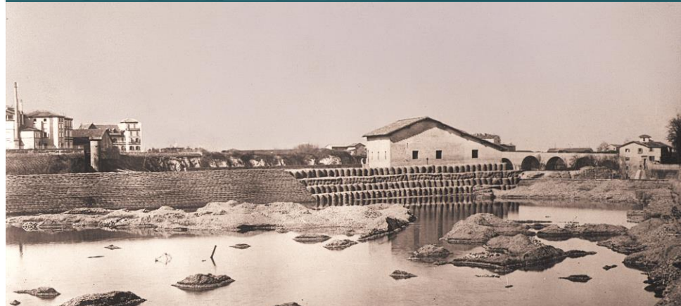
Trabajos en la presa de Casalecchio (Bolonia, Italia), 1893.
