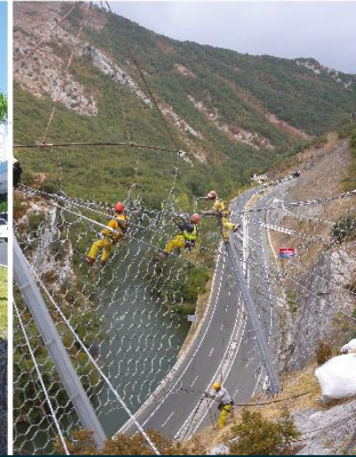
Control de Caída de Rocas
