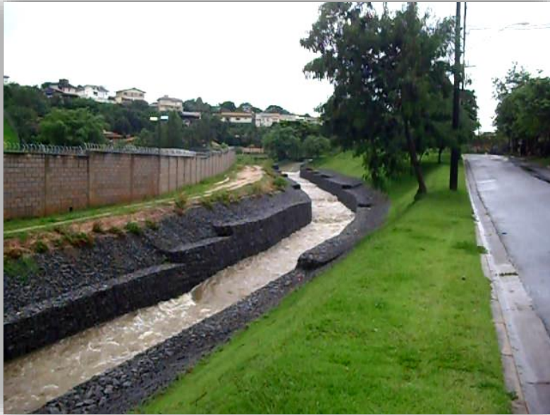
Canalización Condominio Marambaia Caudal en un día de lluvia fuerte
