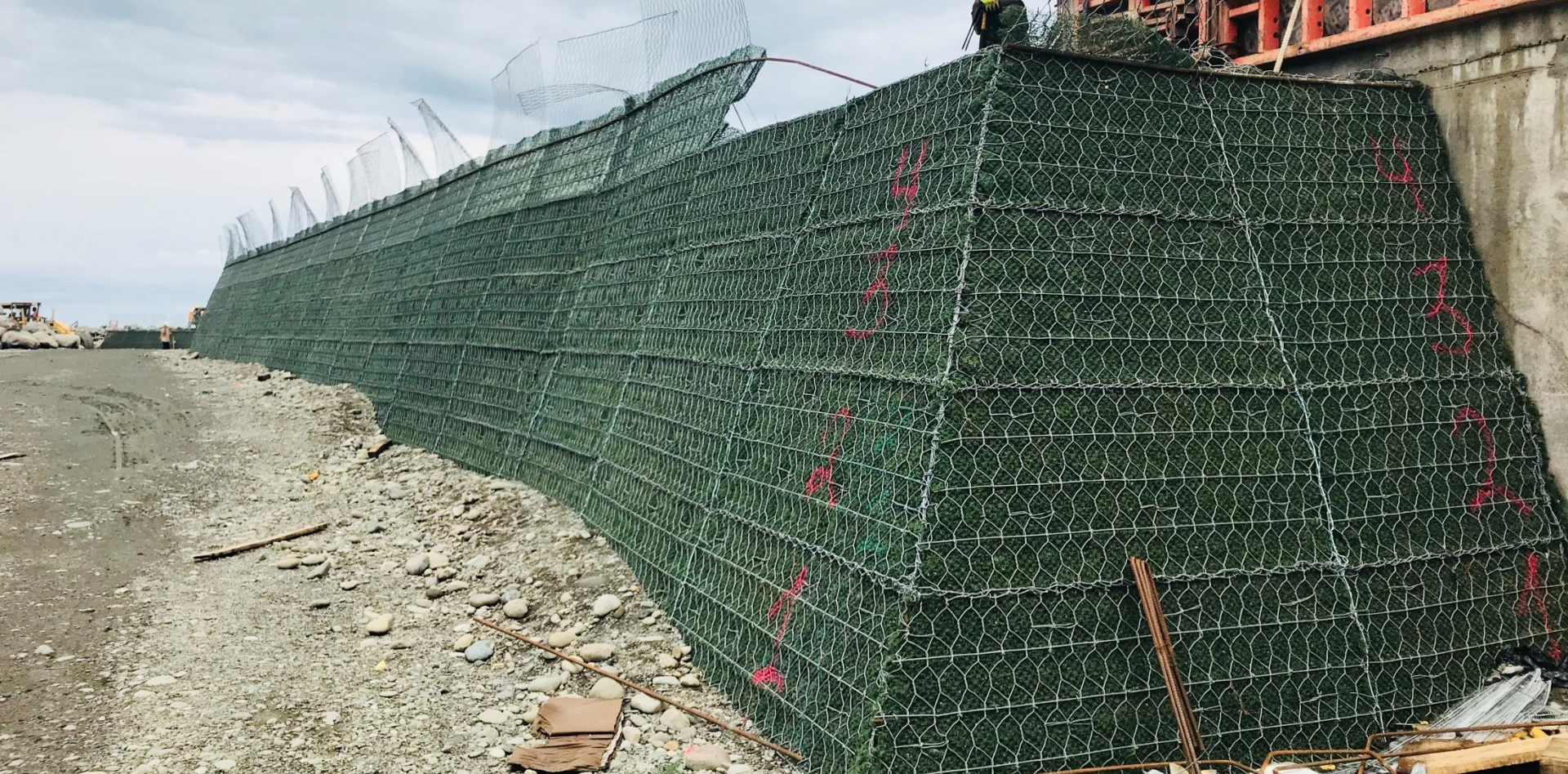
Estructura de Contención en Suelo Reforzado, Costa Rica | Terramesh® Verde
