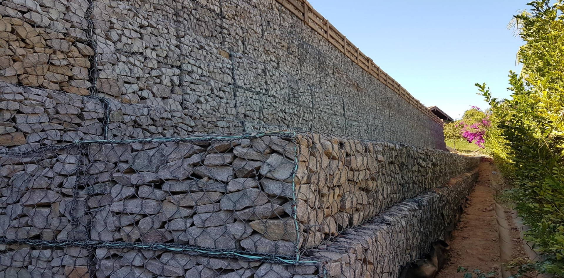
Estructura en Suelo Reforzado, Brasil | Terramesh® System
