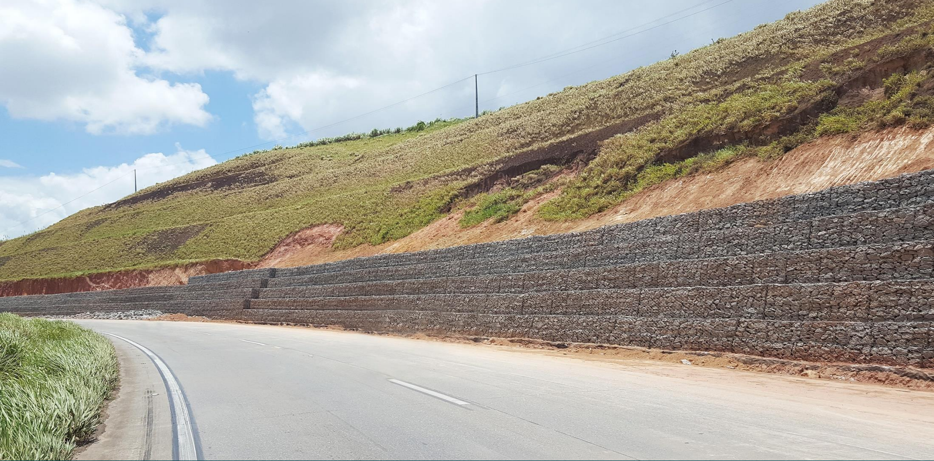
Muro de Contención a gravedad, Brasil | Gavión Caja
