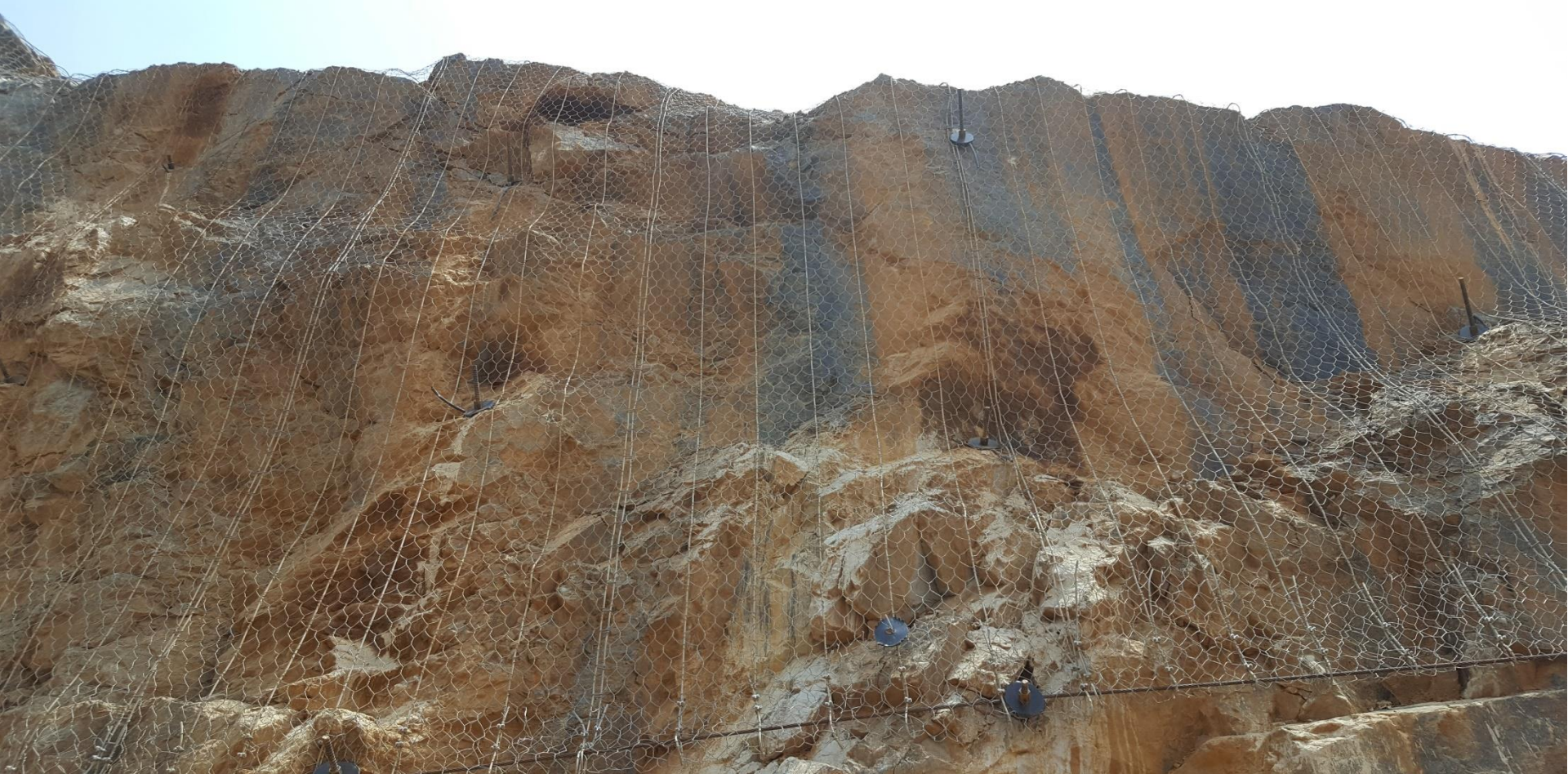
Revestimiento y protección de encosta rocosa, Brasil | SteelGrid®
