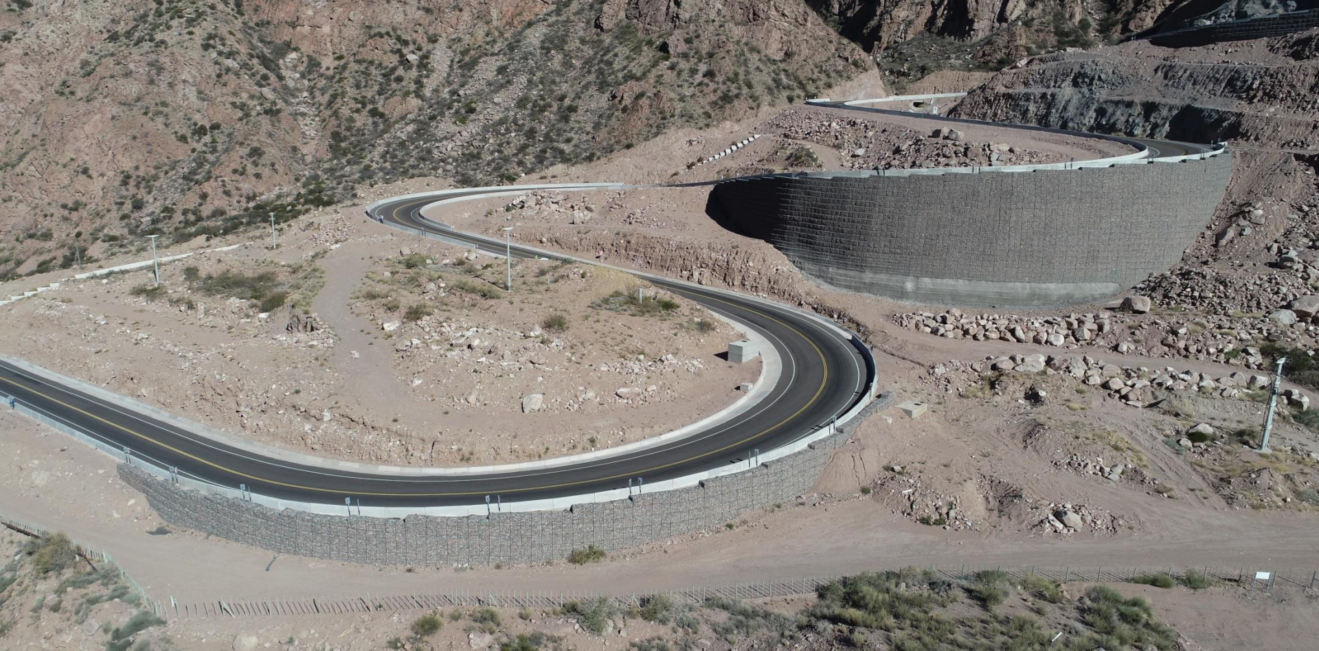
Estructura en Suelo Reforzado, Argentina | Terramesh® System
