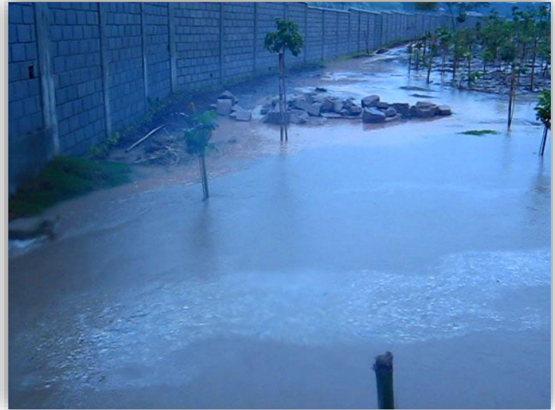
Canalización Condominio Marambaia Caudal en un día de lluvia extrema
