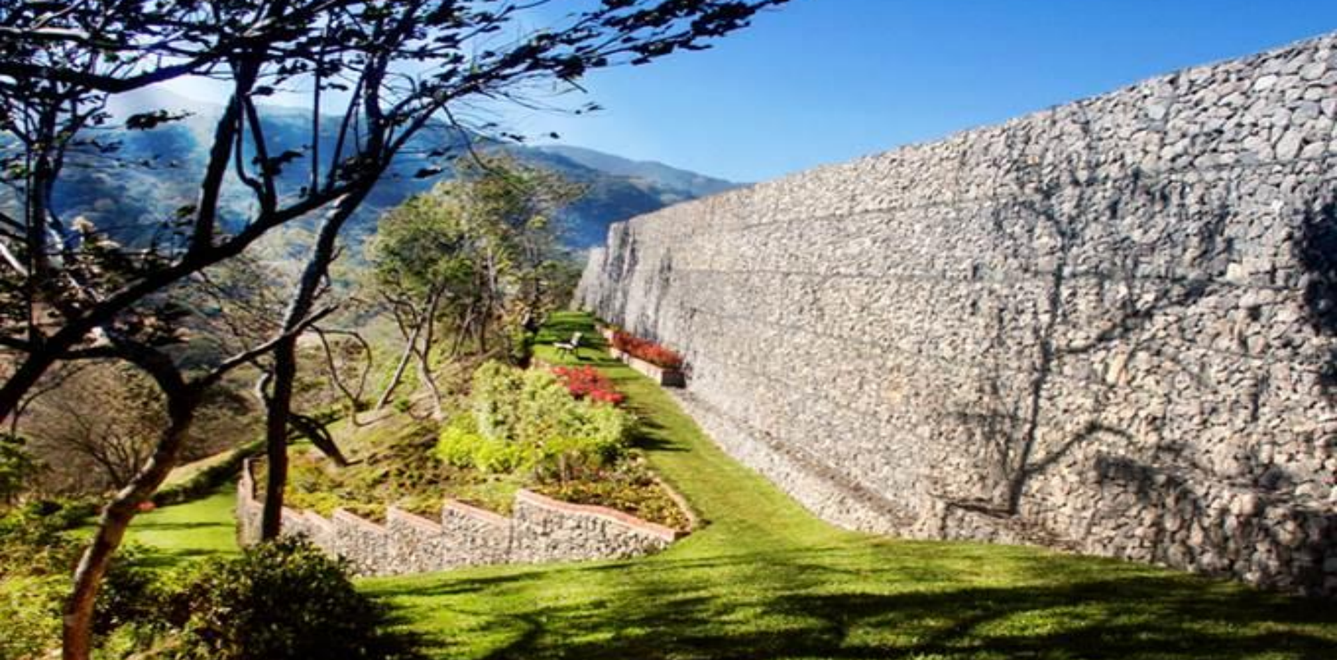
Muro de Contención a gravedad, Costa Rica | Gavión Caja
