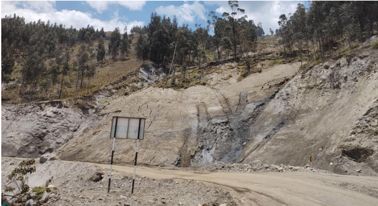
CONSTRUCCION DE LA CARRETERA HUALLANCA LA UNION - HUANUCO
