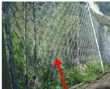
Estructura de interceptación (módulo funcional)
