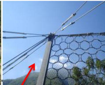
Elementos de Disipación de Energía
