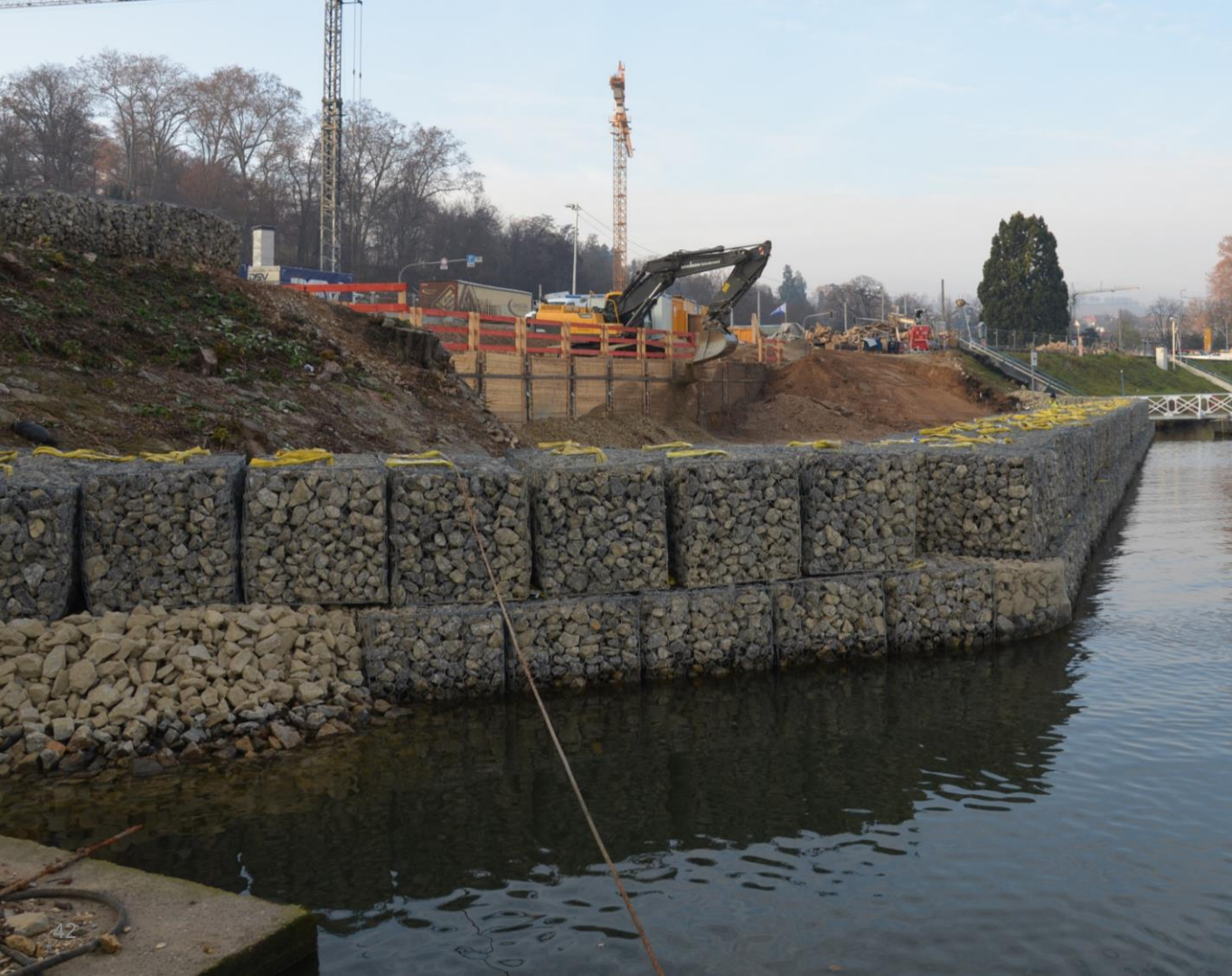
Muros de contención y refuerzo del suelo Stuttgart, Alemania
