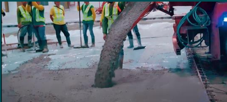
2 Fiber concrete pouring
