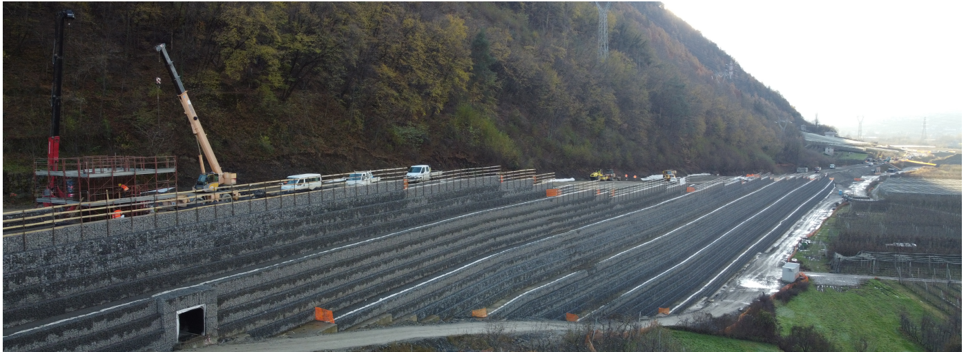
Ripresa con drone delle strutture in terra rinforzata con dettaglio dell'attraversamento idraulico
