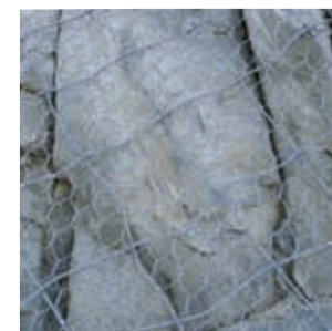
3 Systèmes de grillage et filets pare-éboulis- plaqués
