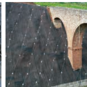
6 Confortement et clouage
