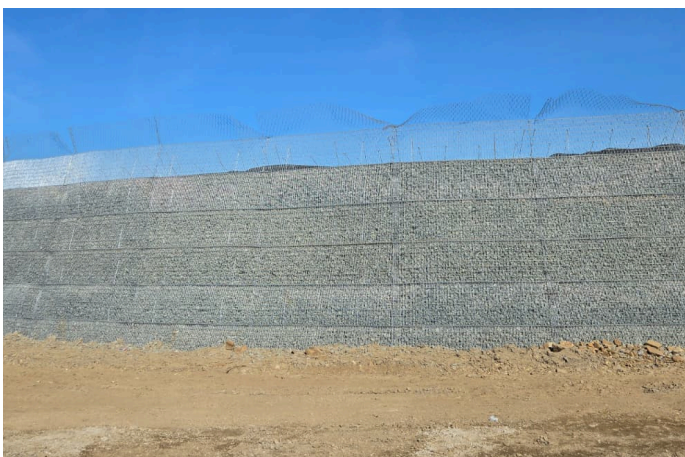
Konštrukcia Mineral Terramesh® v oblúku
