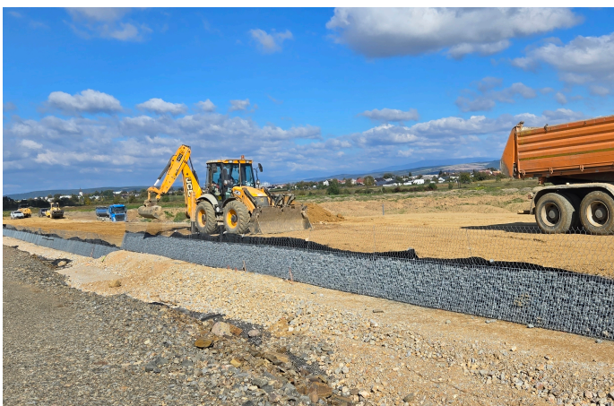
Pokládka prvej rady systému Mineral Terramesh®
