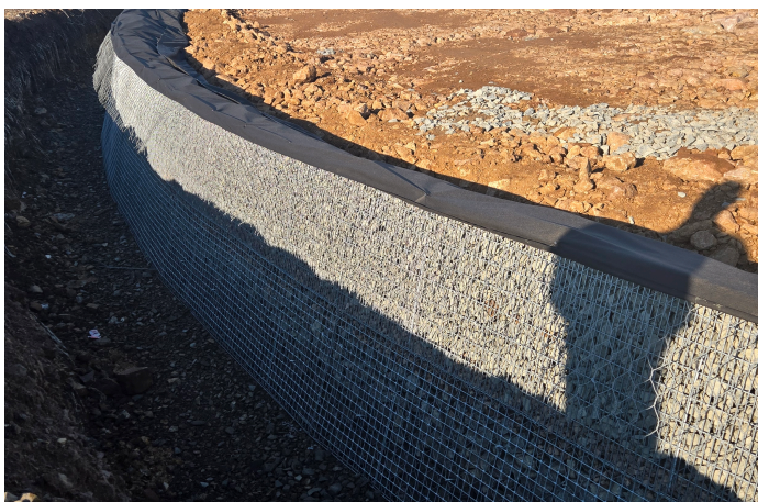
Pokládka prvej rady systému Mineral Terramesh® v oblúku
