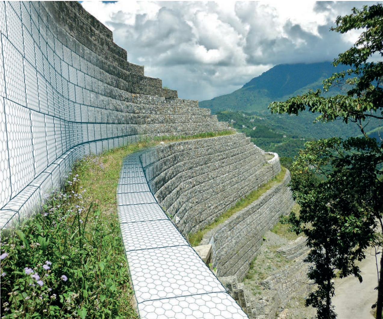
MacSTARS ha permesso la progettazione di strutture di particolare complessità
