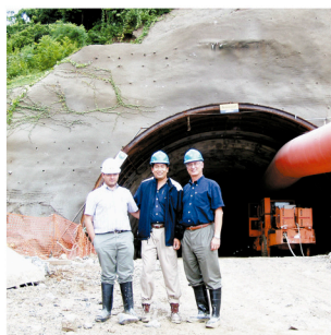
Visitas técnicas às obras
