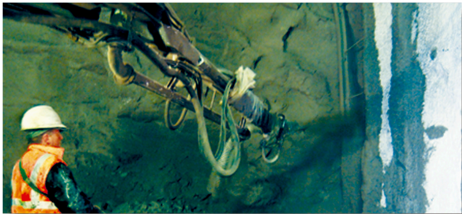
Concreto projetado com fibras.
