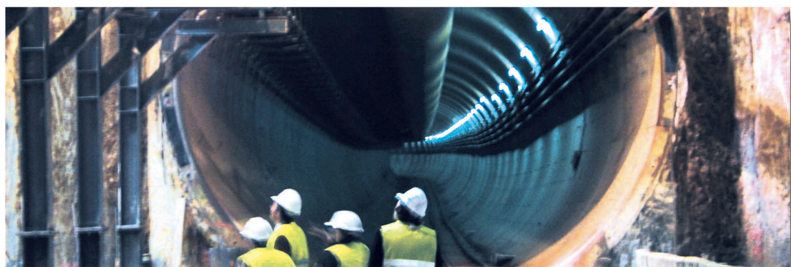
Inspeção da obra
