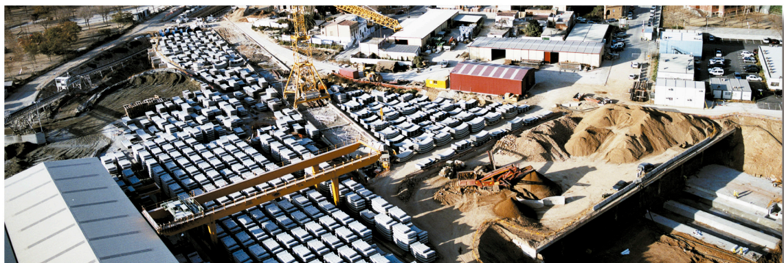
Aduelas de concreto
