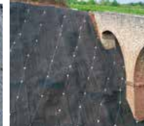
6 Soil Nailing y Protección de la superficie.
