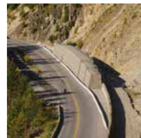
1 Terraplenes contra caídos de rocas y derrumbes.
