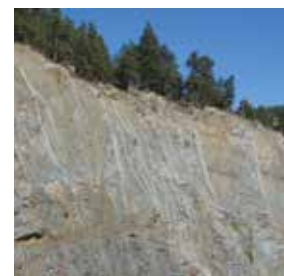
2 Sistemas de Malla – Revestimiento Simple.
