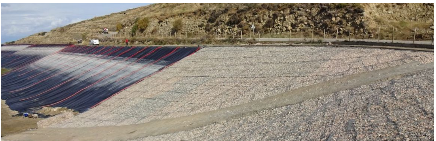
ΠΡΟΚΑΤΑΣΚΕΥΑΣΜΕΝΕΣ ΣΤΡΩΜΝΕΣ RENO ΠΡΙΝ ΤΗΝ ΟΛΟΚΛΗΡΩΣΗ ΤΟΥ ΕΡΓΟΥ
