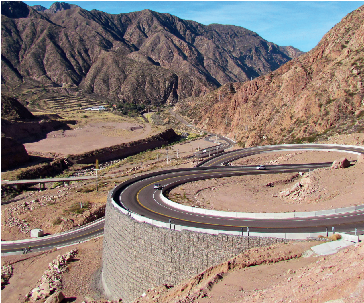
Contención en Suelo Reforzado
