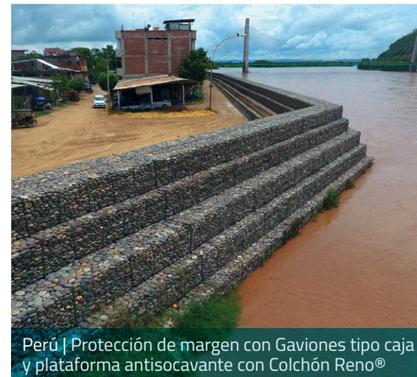
Perú | Contención de margen con Gaviones tipo caja y plataforma antisocavante con Colchón Reno®
