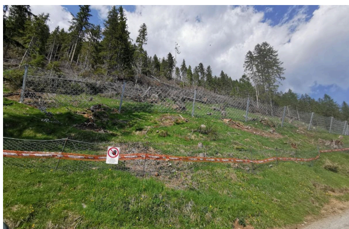
Vista di una delle tratte di barriere paramassi RB 2000
