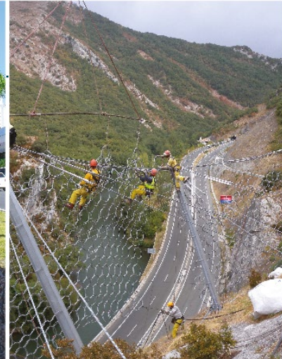
Control de Caída de Rocas
