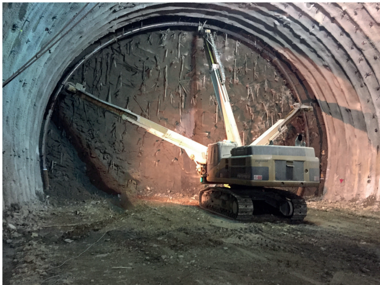
Galleria Boscaccio (Calcari marnosi appartenenti alla formazione del Monte Morello): apertura centina tubolare automatica.
