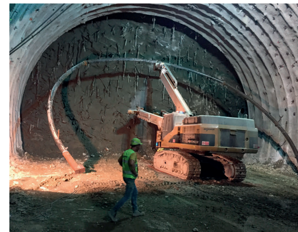
Galleria Boscaccio (calcari marnosi appartenenti alla formazione del Monte Morello) sollevamento centina tubolare automatica
