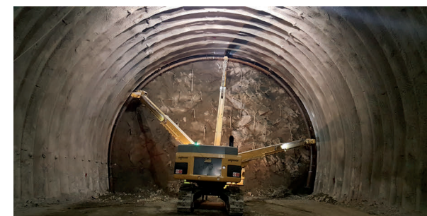
Galleria Boscaccio (Calcari marnosi appartenenti alla formazione del Monte Morello) installazione centina tubolare automatica
