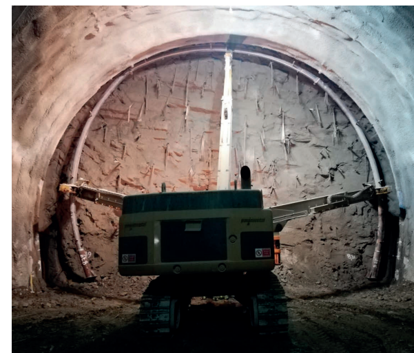
APERTURA E POSIZIONAMENTO PIEDRITTI Nessun operatore al fronte
