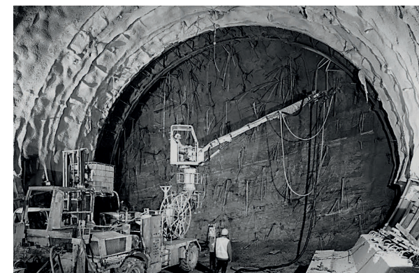
Galleria "Tartaiguille" (argille montmorillonitiche): nucleo-fronte rinforzato con armature di vetroresina ed esecuzione del tampone di fondo mediante calcestruzzo proiettato (1997)
