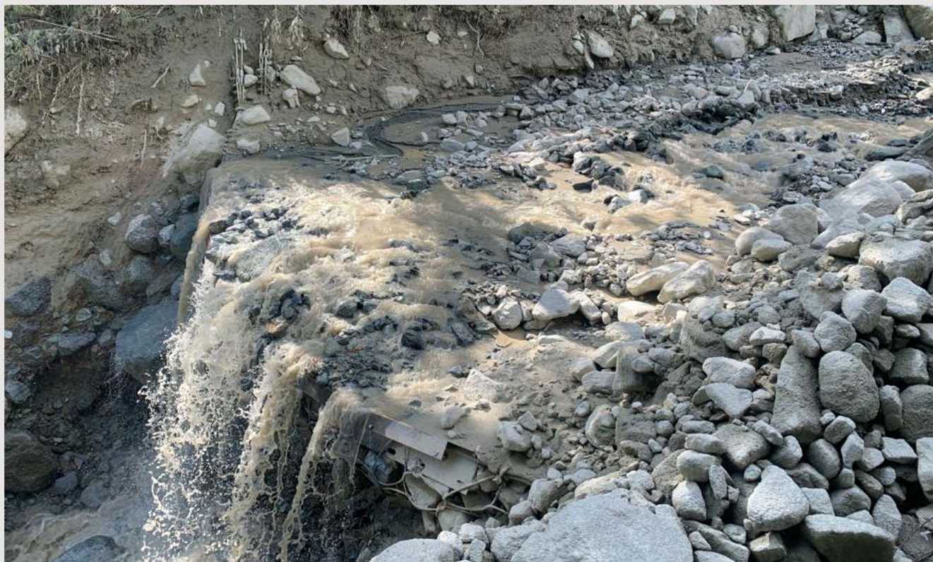
Barrière certifiée CE après la survenue d'un événement de laves torrentielles.
