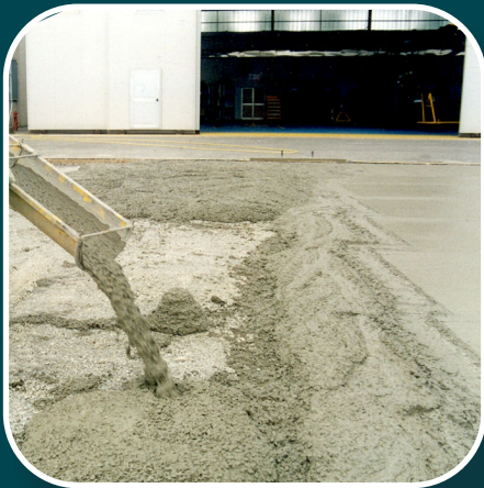
Pisos y pavimentos
