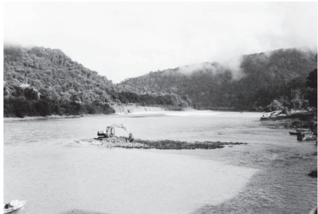
Durante la obra
