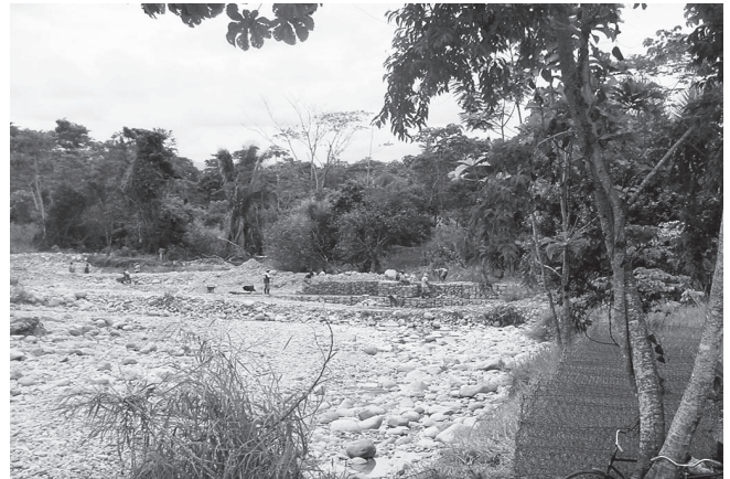
Durante la obra
