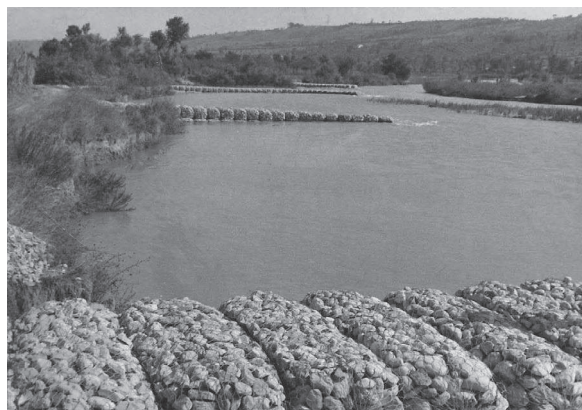
Figura 4.2.4 - Espigón construido en agua con gaviones saco.
