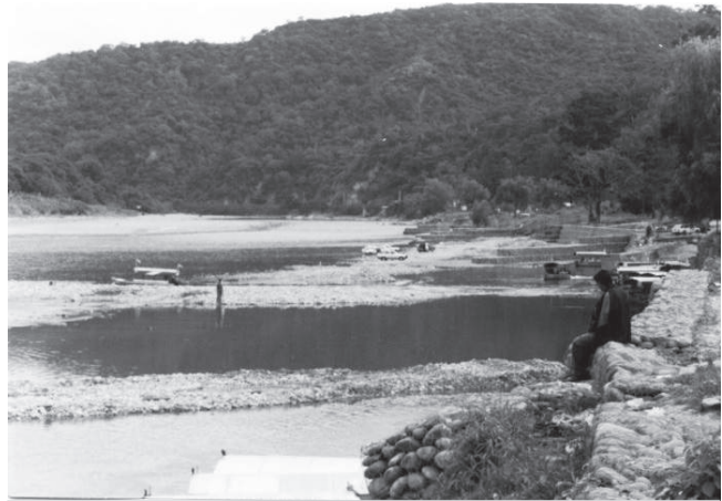
Durante la obra
