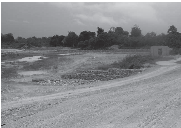
Figura 4.2.8 - Espigones en gaviones.
