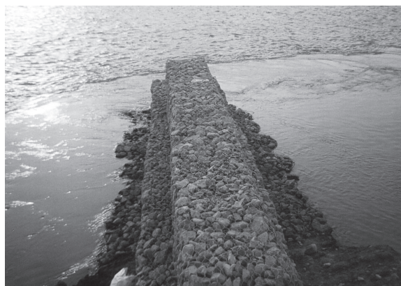
Figura 4.2.5 - Espigón en gaviones construido en agua en dos etapas: bajo agua con gaviones saco y en seco con gaviones caja.
