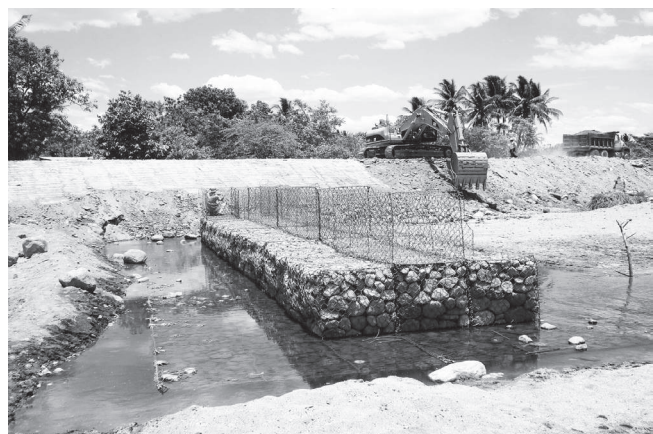
Durante la obra
