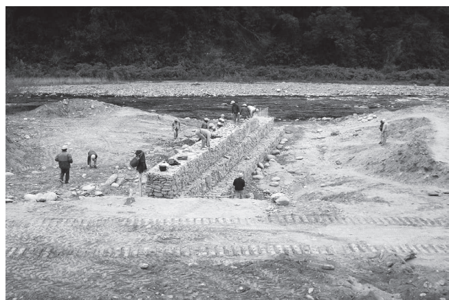
Durante la obra
