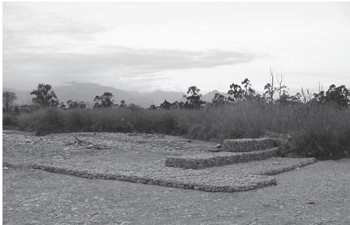
Figura 3.9.7 - Protección antierosión de espigón en gaviones.
