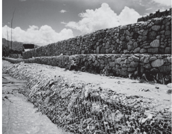
Figura 4.1.13 - Plataforma después de mayores erosiones.
