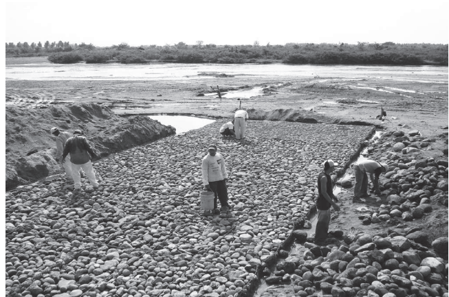
Durante la obra
