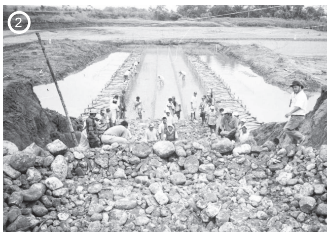
Durante la obra
