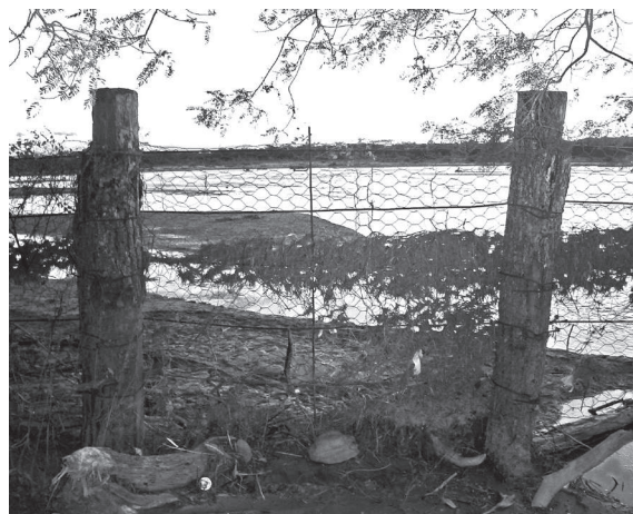
Figura 5.4 – Espigões em material misto.
