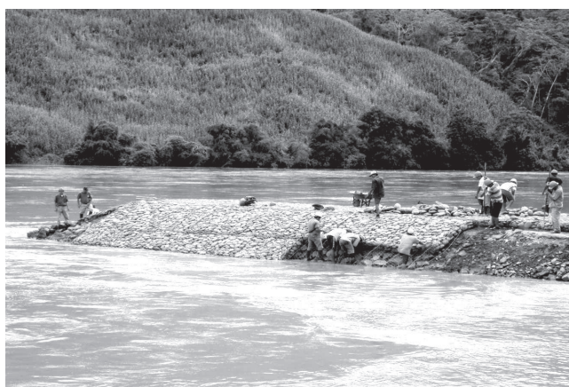
Durante la obra
