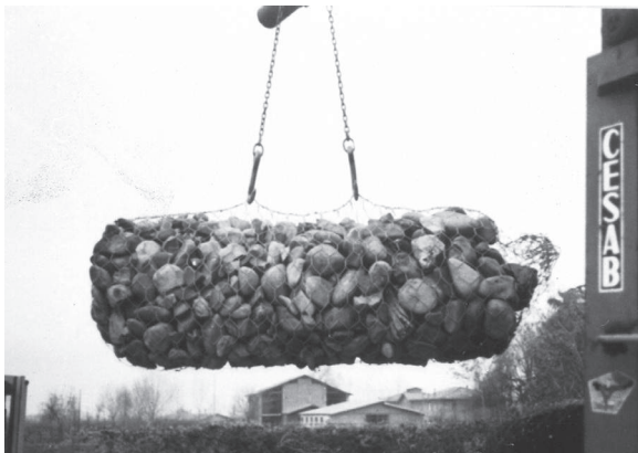
Figura 4.2.1 - Colocación en agua de gaviones saco.
