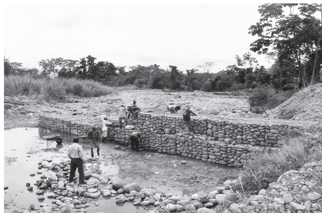
Durante la obra
