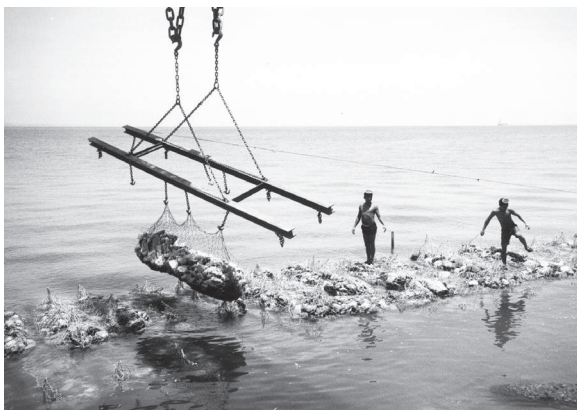
Figura 4.2.3 - Colocación en agua de gaviones saco.
