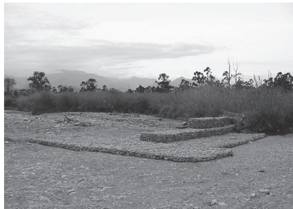
Figura 4.1.16 - Espigón en gaviones con plataforma antisocavación en Colchones Reno® durante la construcción.
