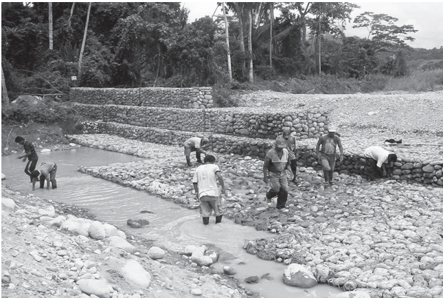
Durante la obra
