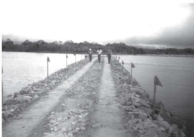
Durante la obra
