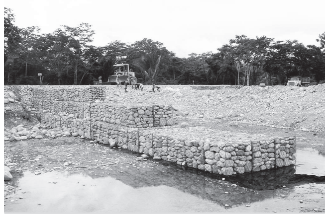
Durante la obra
