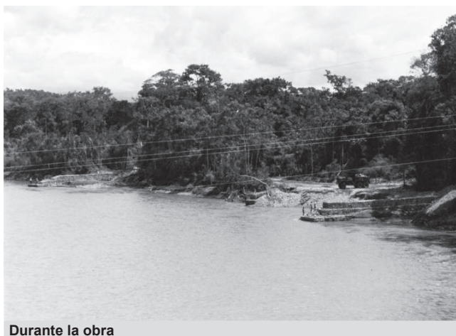
Durante la obra
