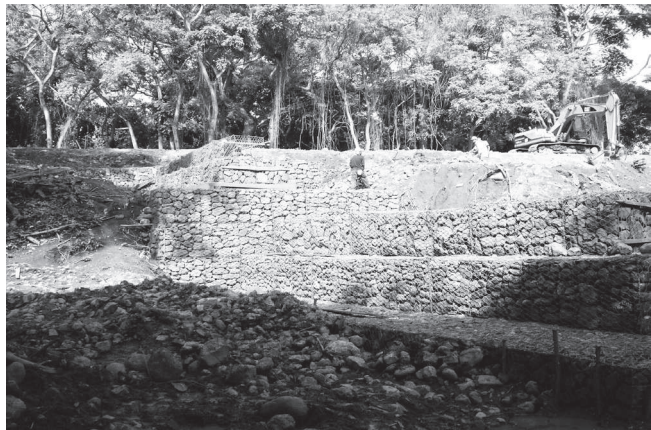
Durante la obra
