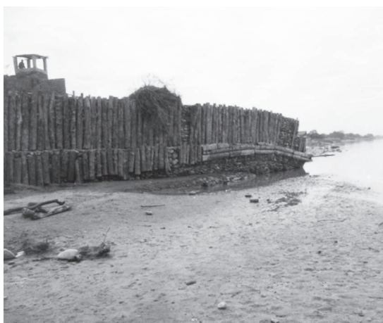
Figura 4.1.6 - Protecciones con troncos contra la abrasión de espigones de gaviones.
