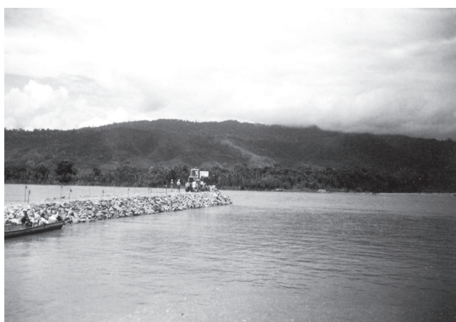
Durante la obra
