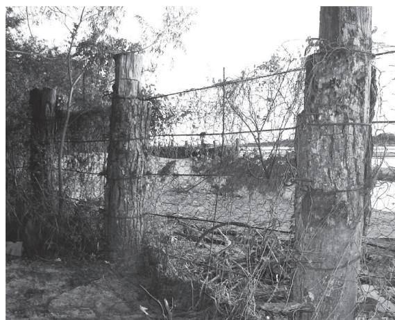
Figura 5.2 – Espigões em material misto.
