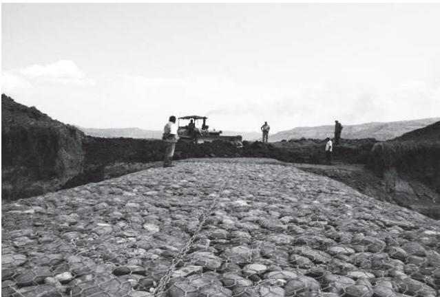
Durante la obra
