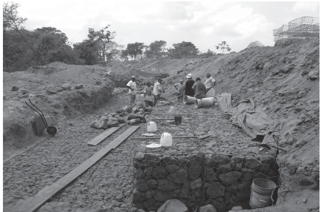
Durante la obra
