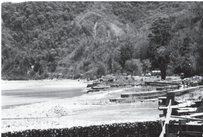
Durante la obra
