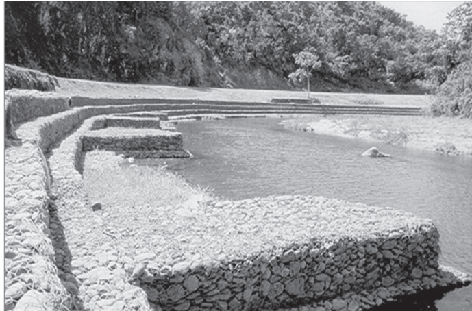
Figura 3.7.3 - Revestimiento del margen a ambos lados del espigón.
