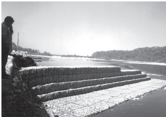
Figura 4.1.15 - Espigones en gaviones con plataforma antisocavación en Colchones Reno®.
