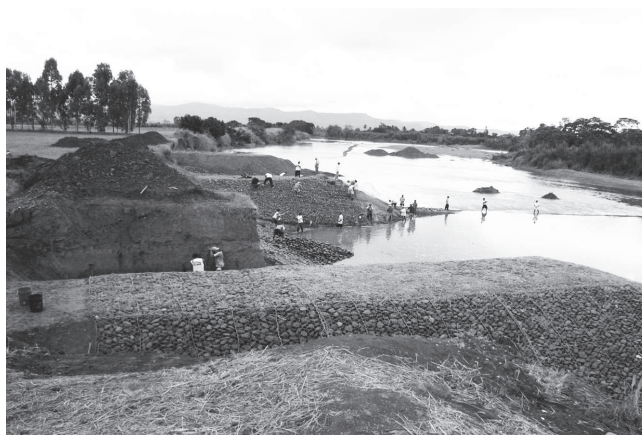
Durante la obra
