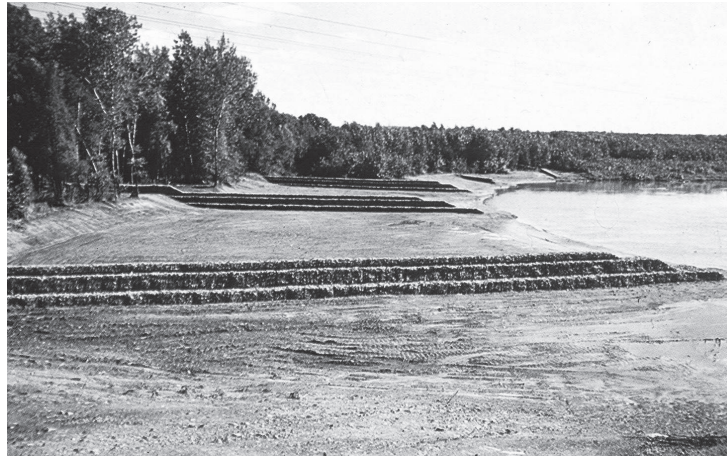
Figura 3.5.1 - Espigón en asta simples.
