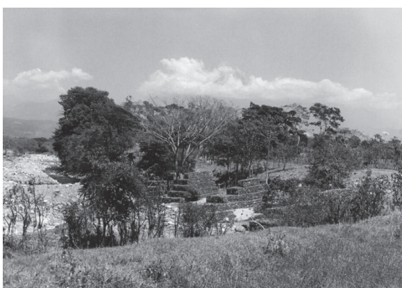
Figura 4.2.10 - Espigones en gaviones.
