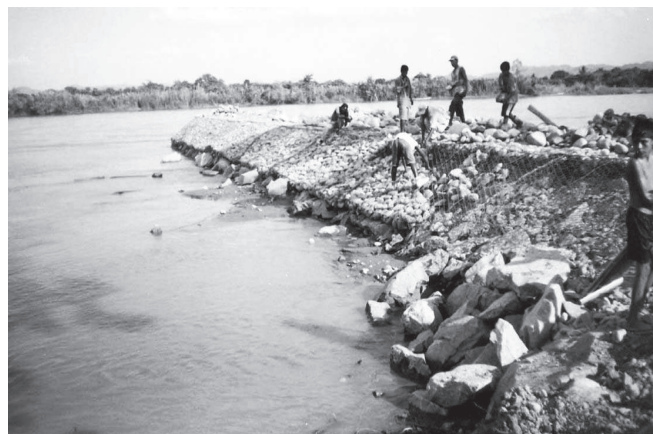
Durante la obra
