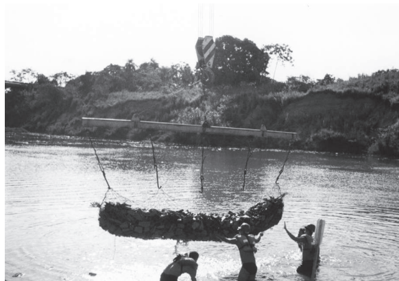
Figura 4.2.2 - Colocación en agua de gaviones saco.
