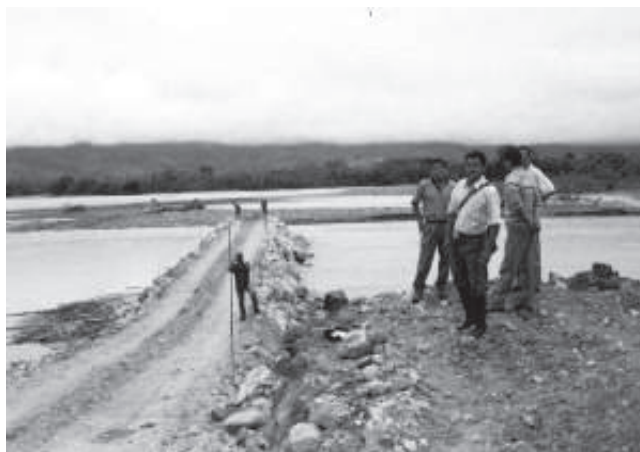
Durante la obra
