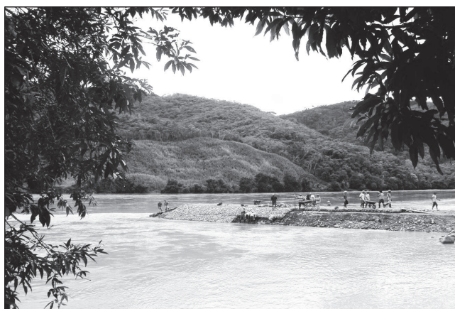
Durante la obra
