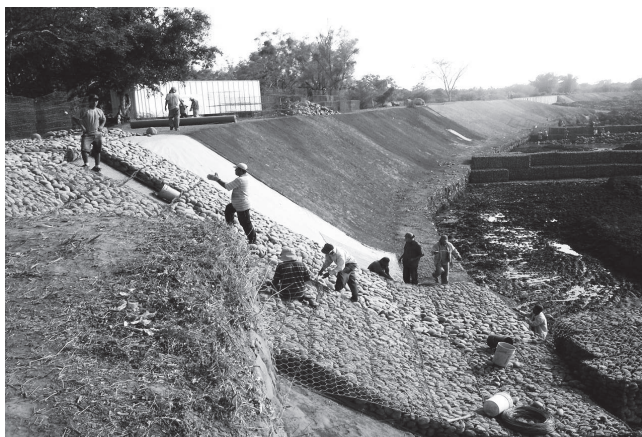
Durante la obra
