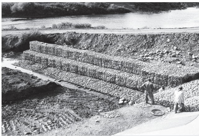
Durante la obra
