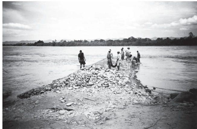
Durante la obra
