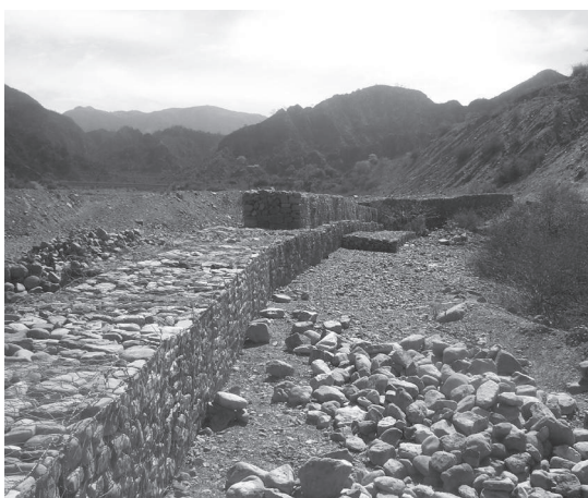
Figura 4.1.5 - Obra construida con gaviones Caja Fuerte®.
