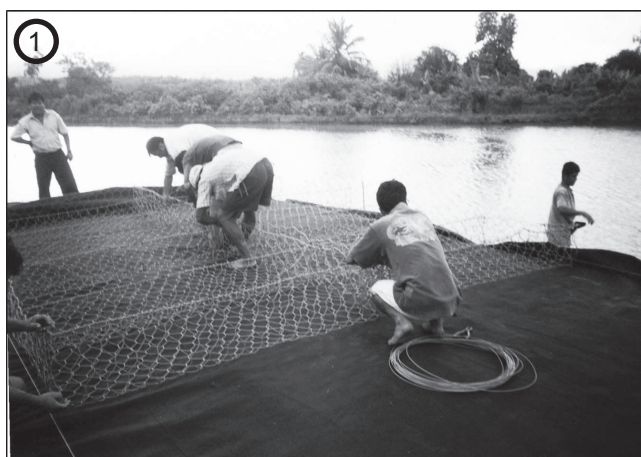
Durante la obra
