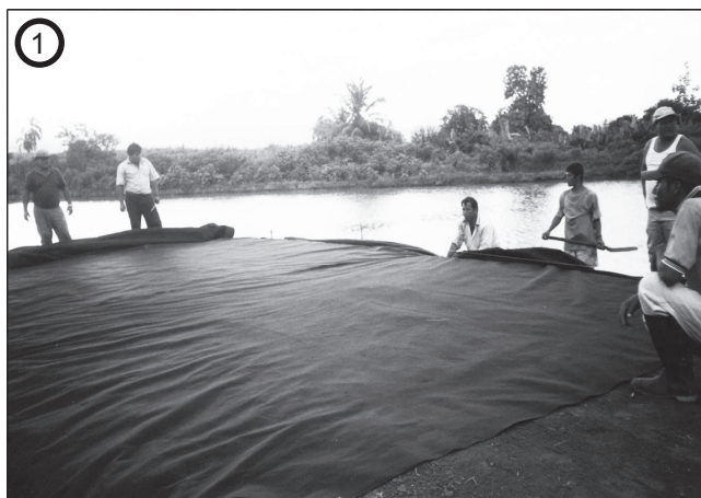
Durante la obra
