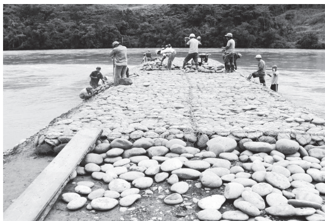
Durante la obra
