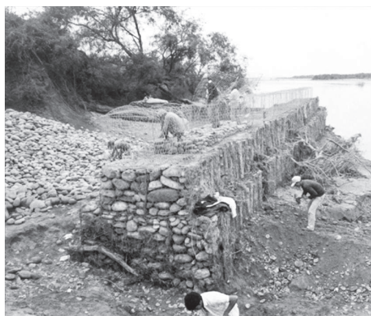
Figura 4.1.6 - Protecciones con troncos contra la abrasión de espigones de gaviones.
