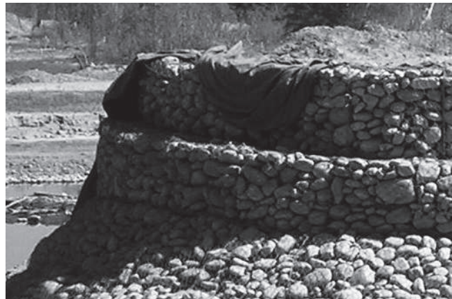
Durante la obra
