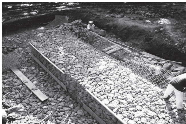
Durante la obra
