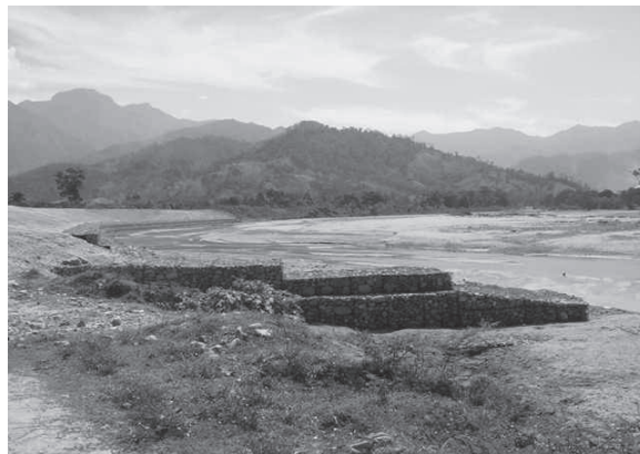
Figura 4.2.9 - Espigones en gaviones.
