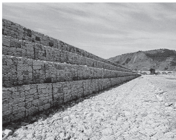
Figura 4.1.10 - Plataforma antisocavación recién construida.
