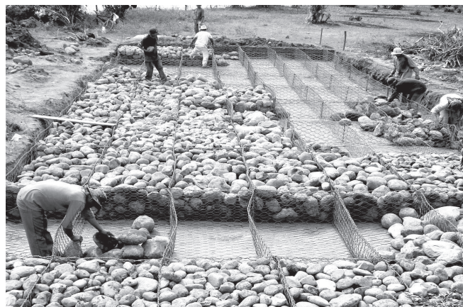
Durante la obra
