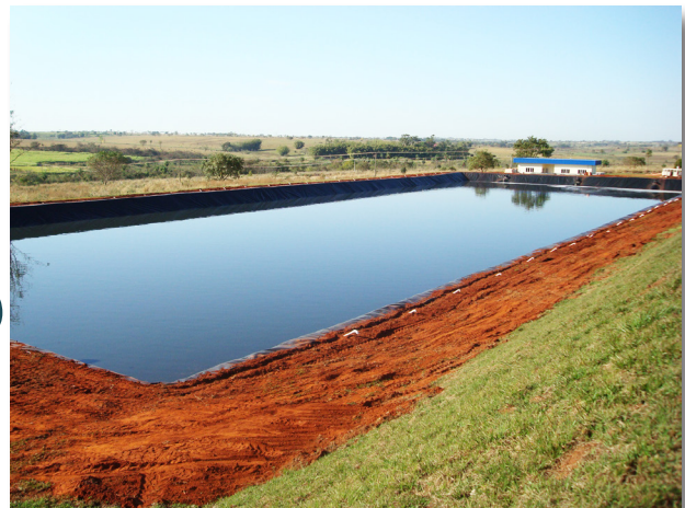
Lagunas de efluentes.
