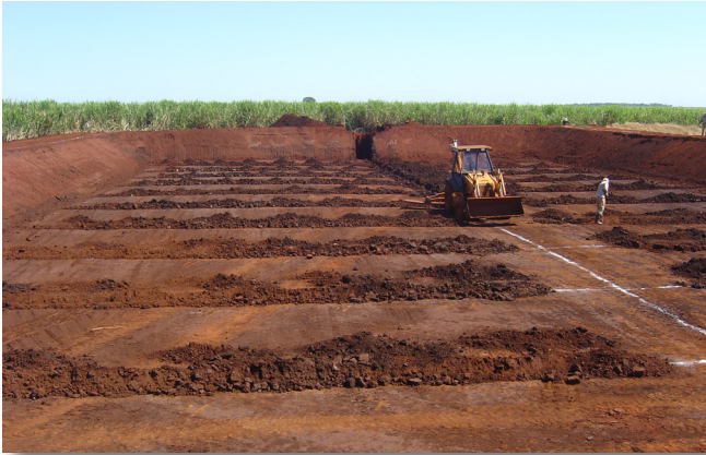
Apertura de las zanjas para drenaje.
