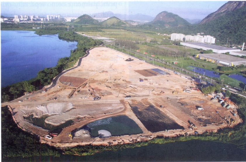
Execução de aterros de conquistas para permitir o acesso à área inicialmente alagada. Optou-se pela substituição por material granular na região, em que havia solo mole até 3 m de profundidade. Nas regiões mais críticas foi utilizado o CPR Grouting
