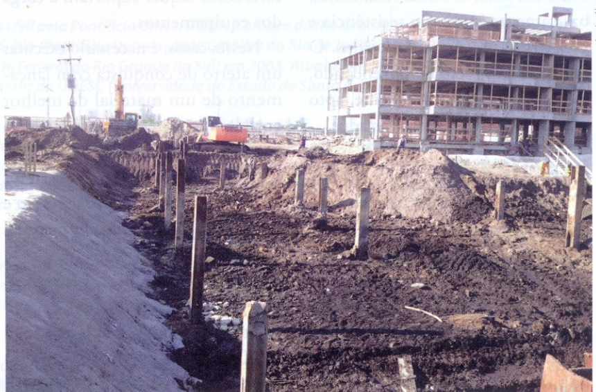
Escavação em solo mole para realização de subsolo. Obra: Pontal Oceânico (RJ)
