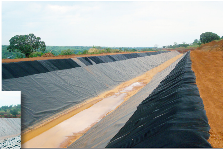
Canal de adução com geomembrana
