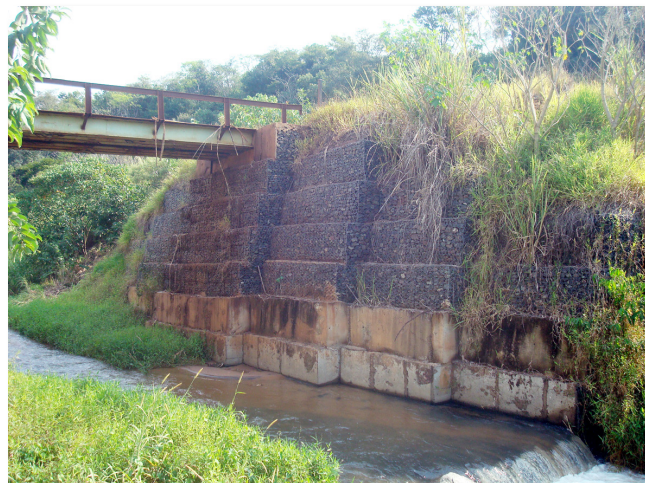
Apoio de pontes em gabiões
