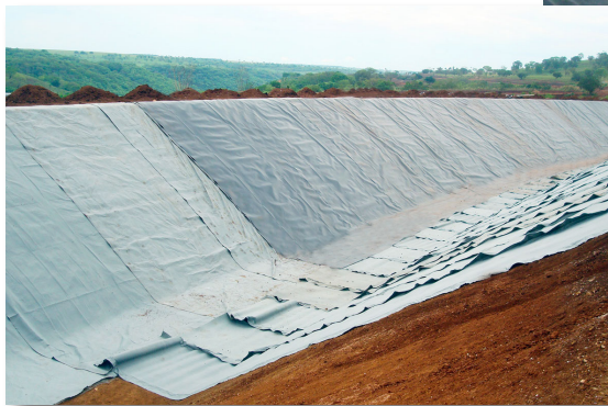
Canal de adução com geomembrana
