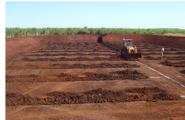
Abertura das valas para drenagem
