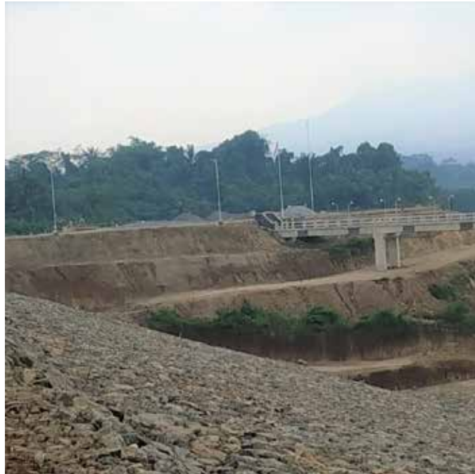
MacMat HS® - Bendungan Sindang Heula, Banten
