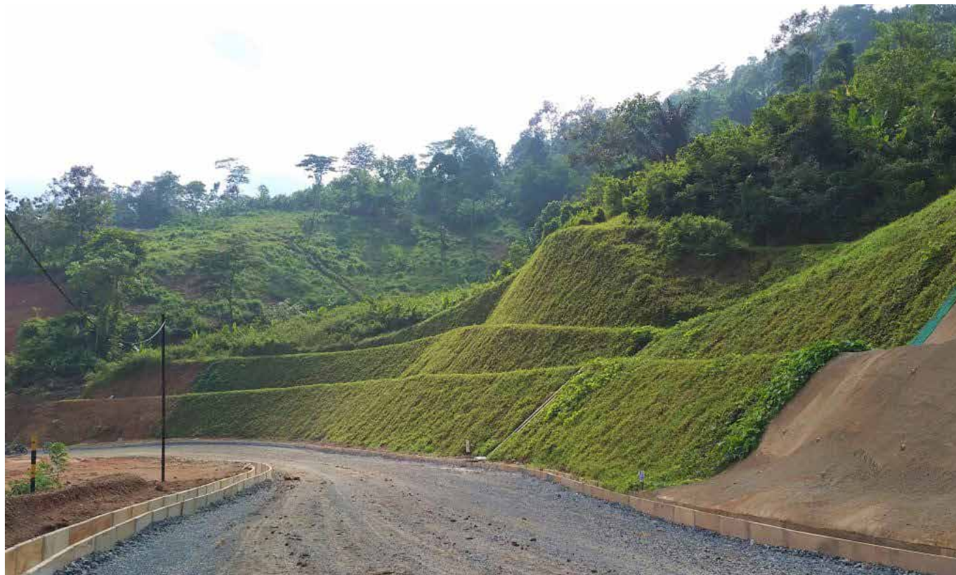
MacMat HS® - Bendungan Way Sekampung, Lampung
