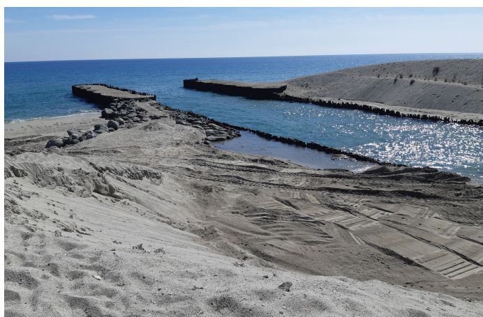
Avant les travaux
