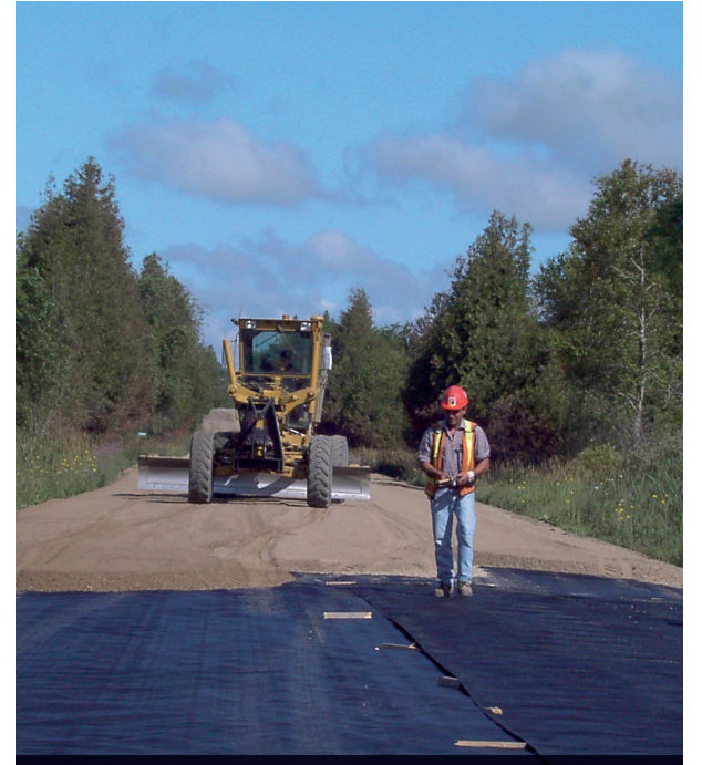
Islak veya yumuşak zeminde erişimin iyileştirilmesi
