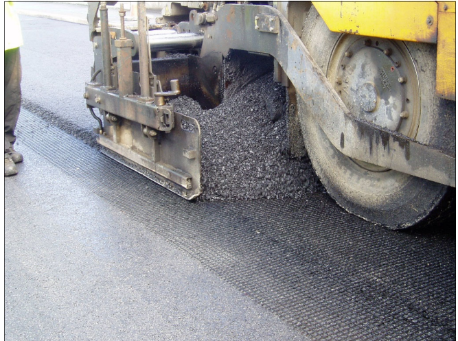
Figure 4: Mise en place des enrobés avec un finisseur à pneu
