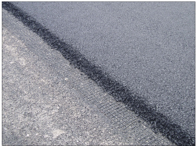
Figure 6: Enrobé placés sur la MacGrid® AR
