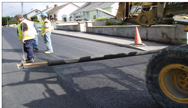
Figure 1: déroulage de la grille à l'aide d'un tube
