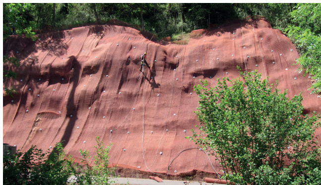
Stabilisation de talus en MacMat® R-Acier
