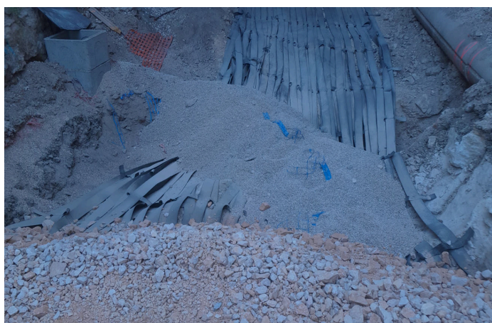
Géogridle monoaxiale mise en place
